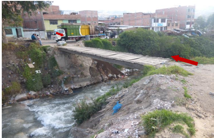
Imagen I-06: accesos peatonales para ingresar al centro. Fuente: Propio.
