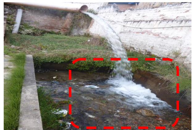
Imagen I-010: ingreso del agua al interior de la Estación Pesquera Fuente: Propio.
