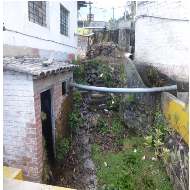
Imagen I-12: estado actual de la infraestructura que se encuentra. Fuente: Propio.
