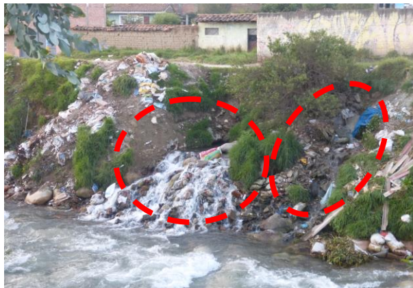
Imagen I-09: aguas servidas que desemboca en el río Fuente: Propio.
