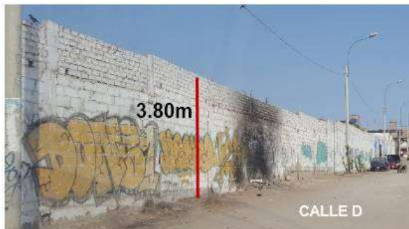
FOTOGRAFIA F-08: Muros de 3.20m a 3.80m en casi el 75% del total del perímetro del grupo N°22 Fuente: Inspección al lugar N. Yauri (Año: 2017)
