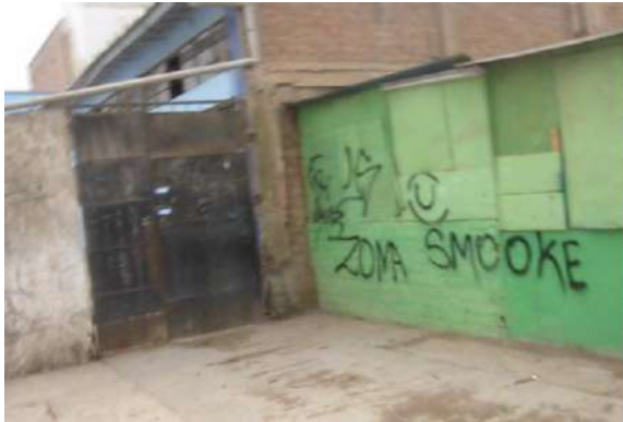
FOTOGRAFÍA F-13: Taller de carpintería construido de triplay y ladrillo Fuente: Inspección al local N. Yauri (Año: 2016)
