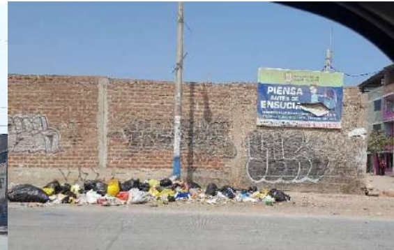
FOTOGRAFÍA F-06: Presencia de basura y desmonte en las vías de tierra compactada Fuente: Inspección al lugar N. Yauri (Año: 2017)
