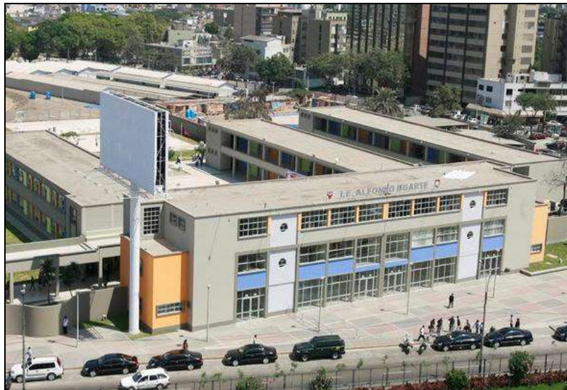
FOTOGRAFÍA F-34: Tesis 03 – Fachada y volumetría
