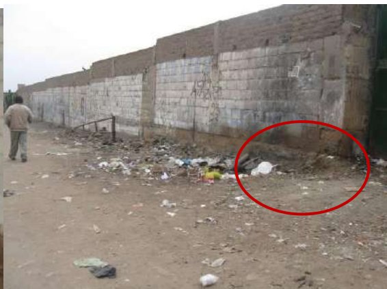
FOTOGRAFÍA F-04: Insuficiencia de veredas en un 42 % de la manzana Fuente: Inspección al lugar N. Yauri (Año: 2017)
