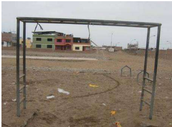
FOTOGRAFÍA F-24: Piso de arena gruesa que ocasiona riesgos de cortes debido a las caídas. Fuente: Inspección al local N. Yauri (Año: 2015)
