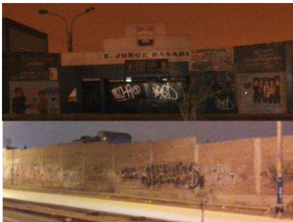
FOTOGRAFÍA F-10: Equipamientos sin uso nocturno, poca iluminación. Fuente: Inspección al lugar N. Yauri (Año: 2016)
