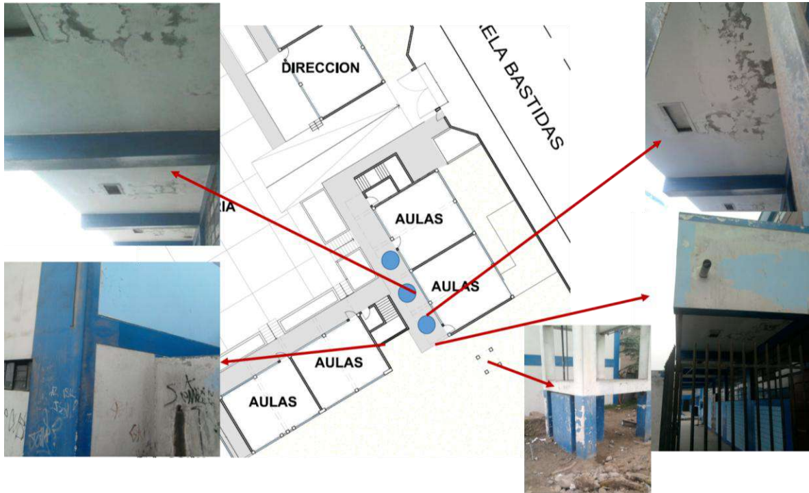
GRÁFICO G-18: Bloque en mal estado por losas deterioradas Fuente: Elaboración propia N. Yauri (Año: 2016)
