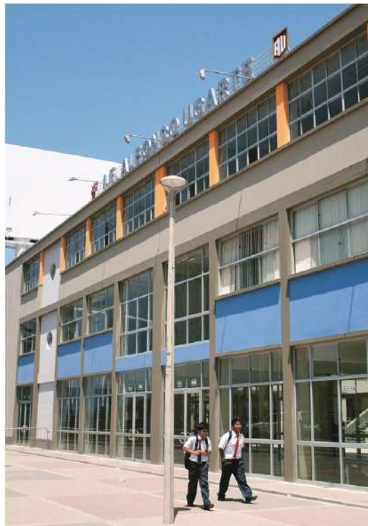
FOTOGRAFÍA F-37: TESIS 03 – FACHADA DEL COLEGIO
