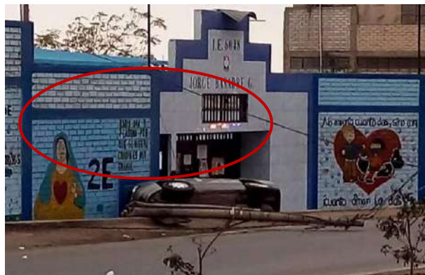
FOTOGRAFÍA F-07: Vereda del ingreso de secundaria tiene un desnivel de 1m de altura - Av. Micaela Bastidas Fuente: Foto de los vecinos del lugar (Año: 2016)
