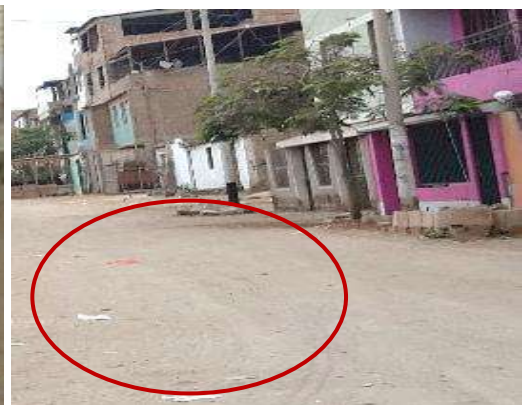
FOTOGRAFÍA F-02: Pista de tierra compactada (Calle C) Fuente: Inspección al lugar N. Yauri (Año: 2017)
