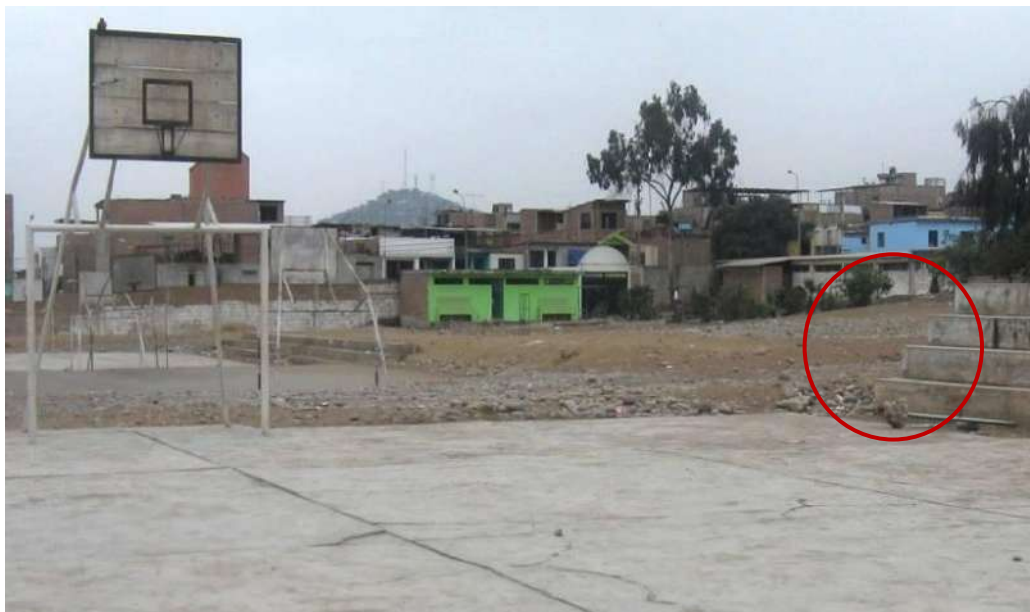
FOTOGRAFÍA F-22: Losas deportivas sin protección auditiva y en mal estado. Graderías sin protección. Fuente: Inspección al local N. Yauri (Año: 2016)
