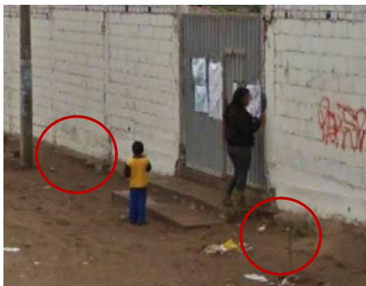
FOTOGRAFÍA F-03: Inexistencia de vías peatonales (Ingreso de inicial) – Calle C Fuente: Inspección al lugar N. Yauri (Año: 2016)
