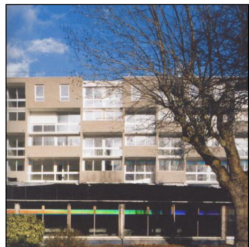
FACHADA HACIA EL PARQUE
