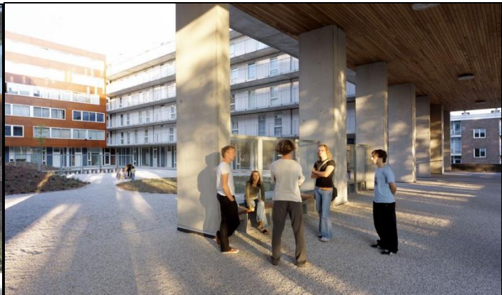
VISTA INTERNA DEL ATRIO ESTE
