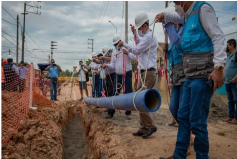
Colocación de tubo en red de tubería
