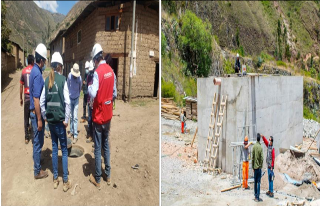
Anexo 7. Vista Fotografica de obra Saneamiento Básico Valle Pincos
