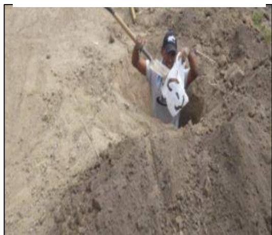
Ilustración 8.- calicatas de exploración subterránea.
