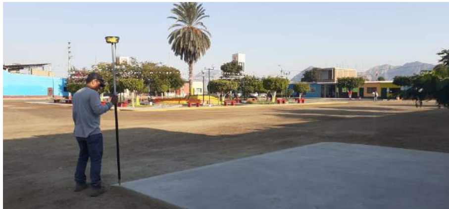
Ilustración 17.-Levantamiento Topográfico de loza existente.
