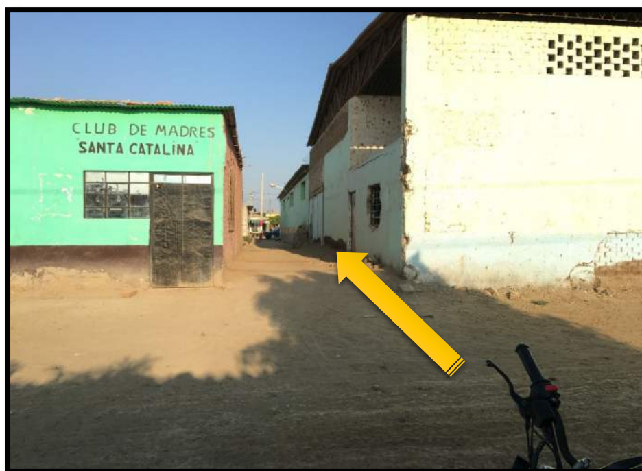
Ilustración 14.-Trocha Carrozable ubicado en el sector C.P Catalina, observación de calle angosta, transitable.
