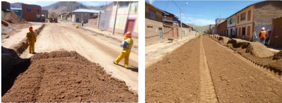
Figura 24 : Extendido, riego y compactado
