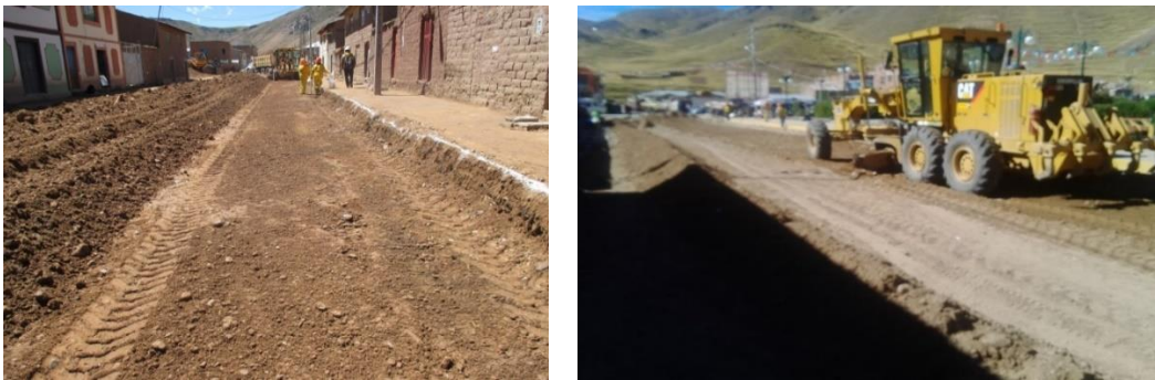
Figura 15 : Corte y eliminación en material compacto
