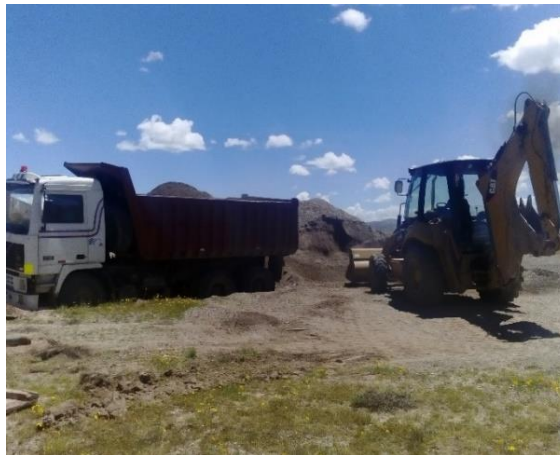
Figura 19 : Extracción cantera y apilamiento de material de hormigón
