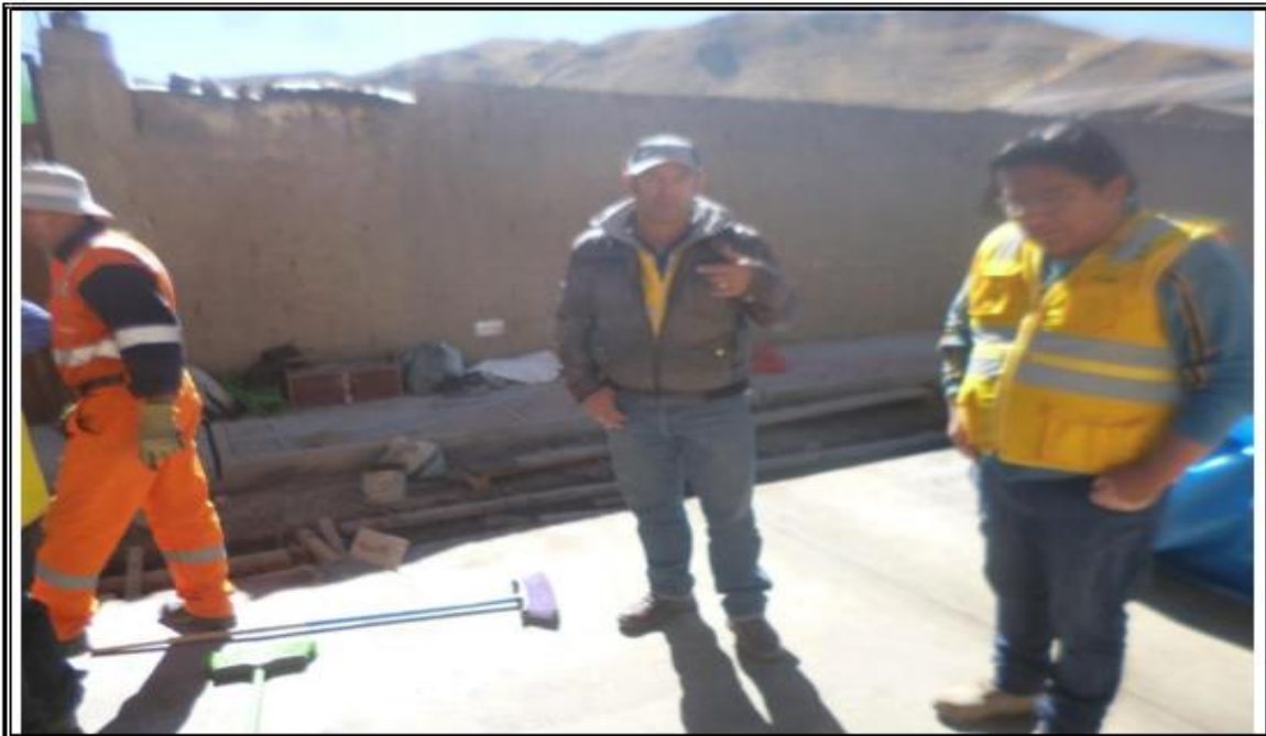
FOTO 01: VISTA PANORÁMICA VACIADO DEL PAVIEMENTO.
