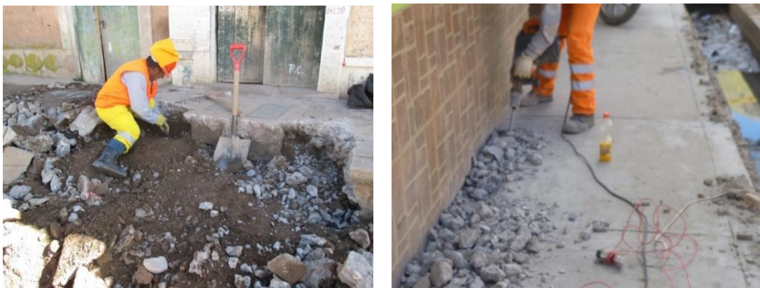
Figura 40 : Demolición de vereda
