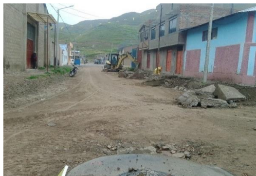
Figura 42 : Corte de terreno manual
