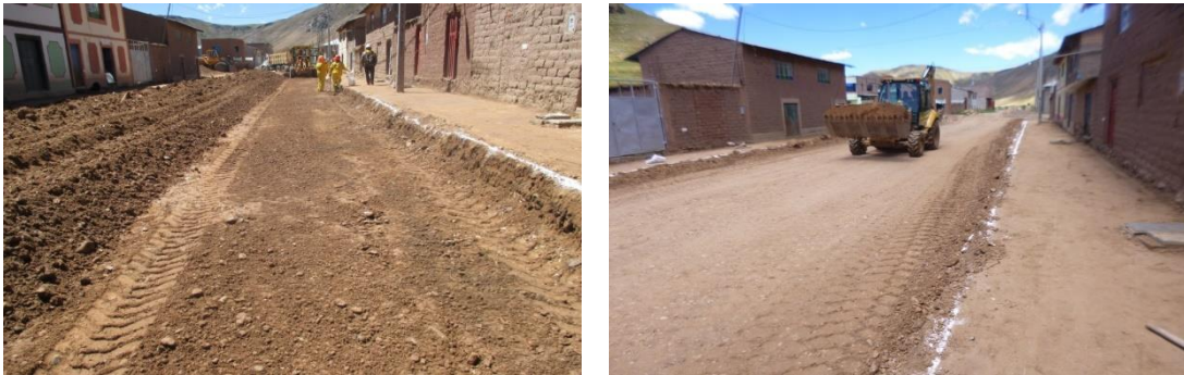
Figura 16 : Perfilado y compactado de subrasante
