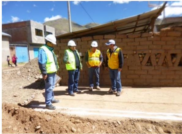
Figura 44 : Conformación manual de subrasante
