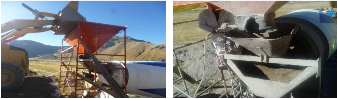
Figura 32 : Preparación de concreto f'c = 210\text{kg/cm}^2 en campo
