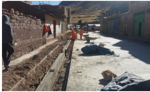
Figura 47 : Encofrado de sardineles
