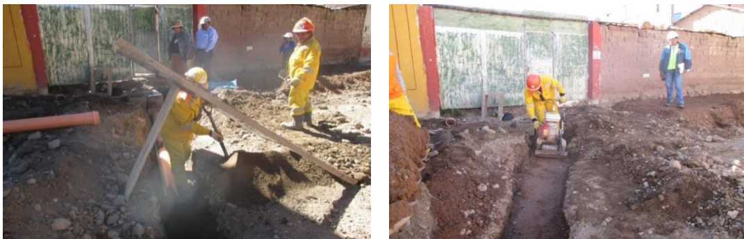
Figura 14 : Protección de tuberías
