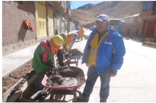
Figura 49 : Vaciado concreto en sardineles
