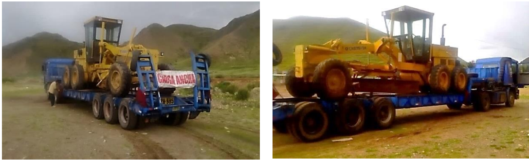
Figura 12 : Movilización de maquinaria
