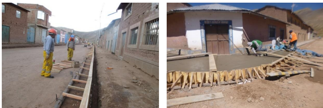
Figura 46 : Encofrado de veredas
