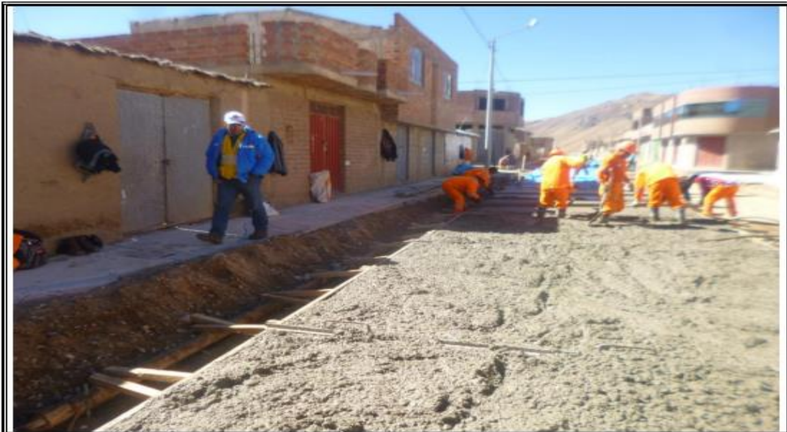
FOTO 09: VISTA PANORÁMICA DEL VACIADO DE PAVIMENTO.
