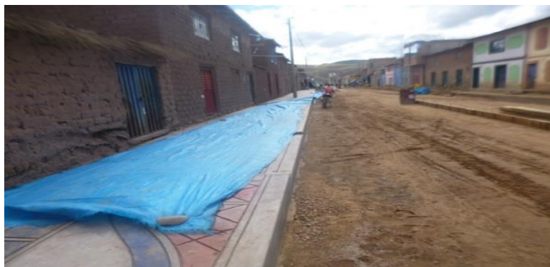
Figura 30 : Encofrado para vaciado de concreto
