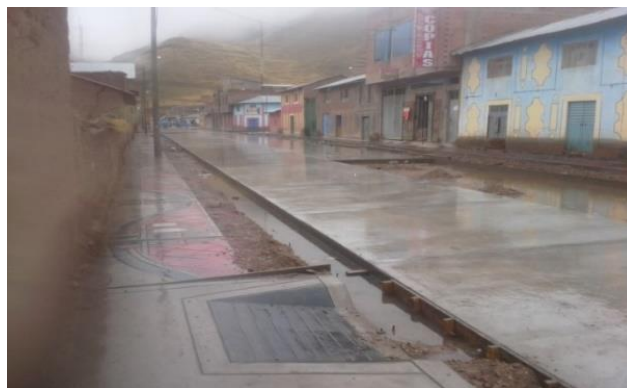
Figura 50 : Curado del concreto
