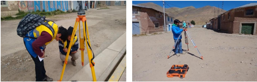
Figura 13 : Trazo y replanteo durante la construcción
