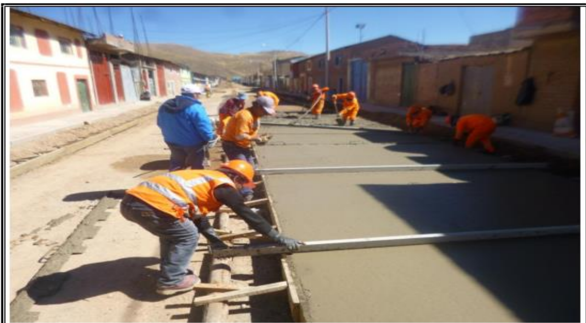
FOTO 10: VISTA PANORÁMICA DEL VACIADO DE PAVIMENTO.
