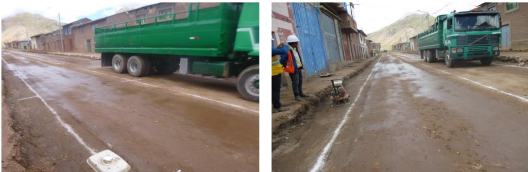
Figura 17 : Riego de la subrasante
