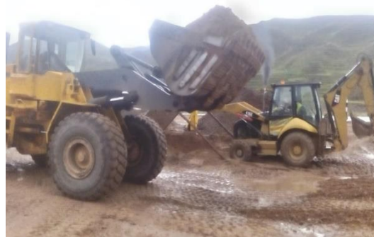
Figura 21 : Transporte de material de cantera para terraplenes.
