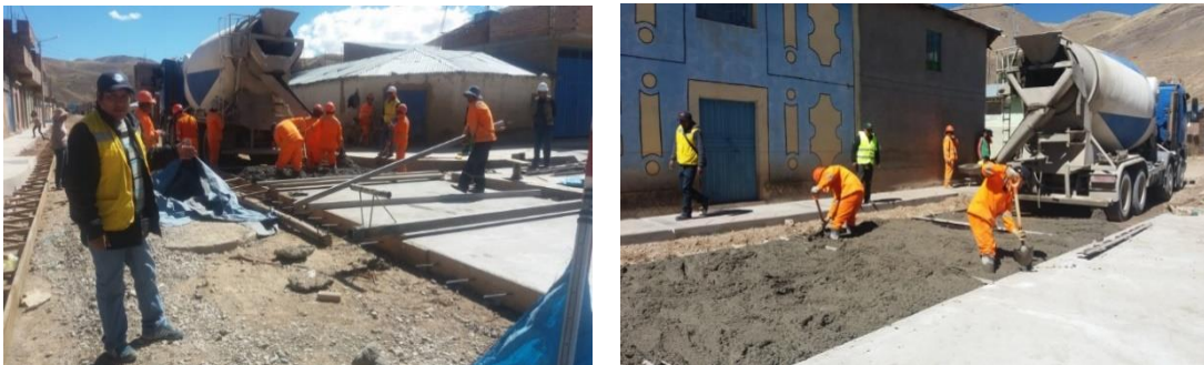
Figura 33 : Colocado de pavimento rígido concreto f'c = 210\text{kg/cm}^2
