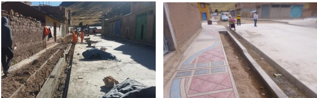
Figura 53 : Encofrado - desencofrado de cunetas
