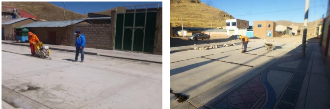
Figura 34 : Colocado y sellado de juntas asfálticas
