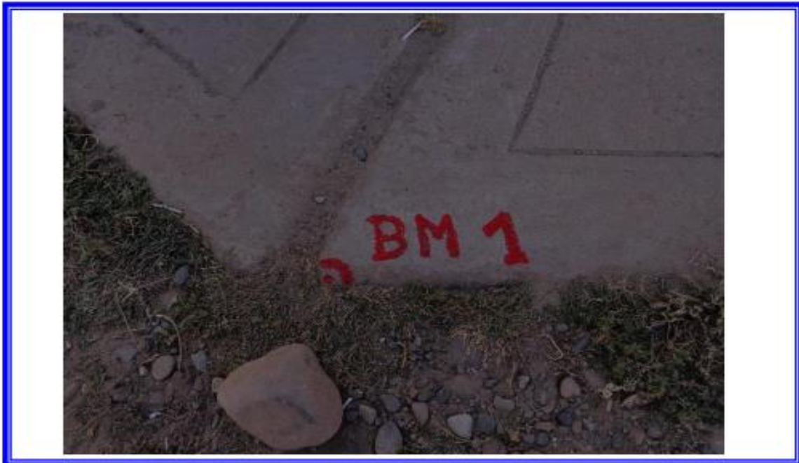
DESCRIPCION SE OBSERVA LA COLOCACION DE BM-1 REFERENCIAL ATAHUALPA CON SINCHI ROCA MONUMENTADO EN VEREDA.
