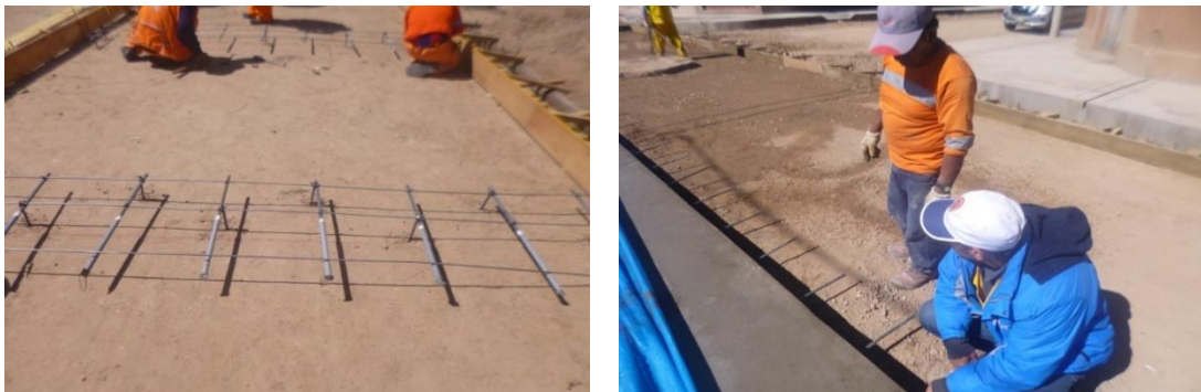
Figura 31 : Instalación de dowels flotantes
