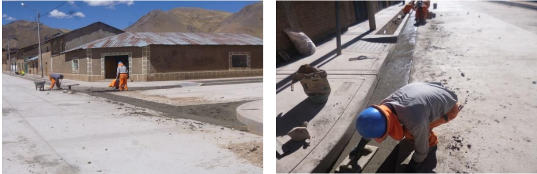
Figura 54 : Vaciado de concreto en cunetas
