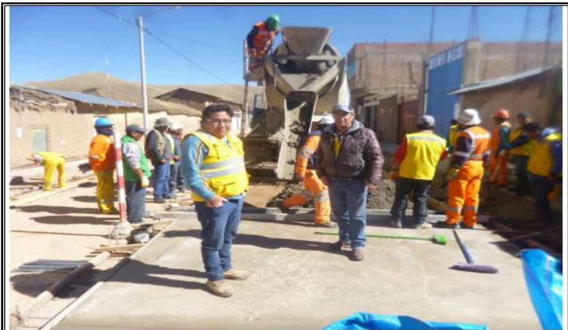
FOTO 02: VISTA PANORÁMICA VACIADO DEL PAVIEMENTO.
