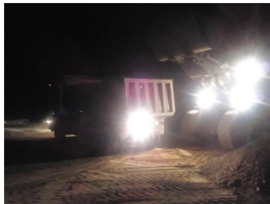
Figura 23 : Transporte de material afirmado
