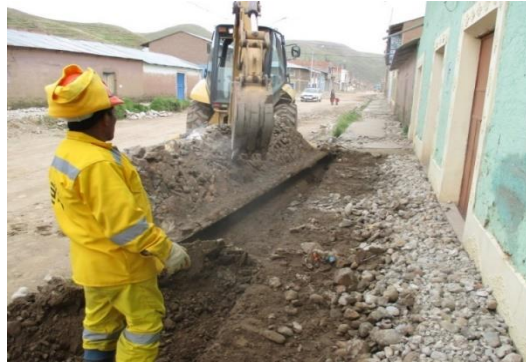
Figura 41 : Eliminación de material excedente
