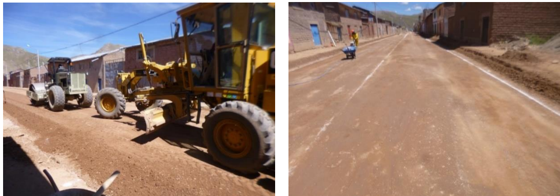
Figura 25 : Nivelación y compactación de sub base
