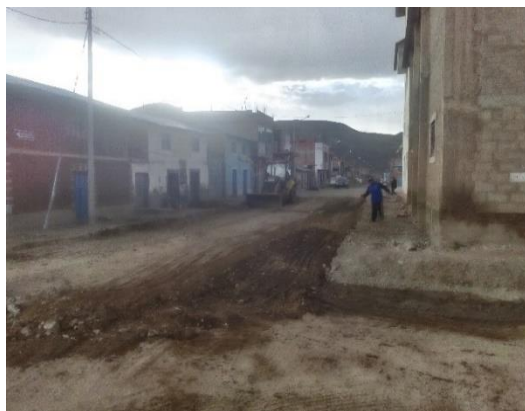
Figura 43 : Excavación de zanjas para sardineles
