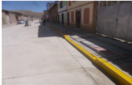
Figura 51 : Colocación de juntas asfálticas en sardineles
