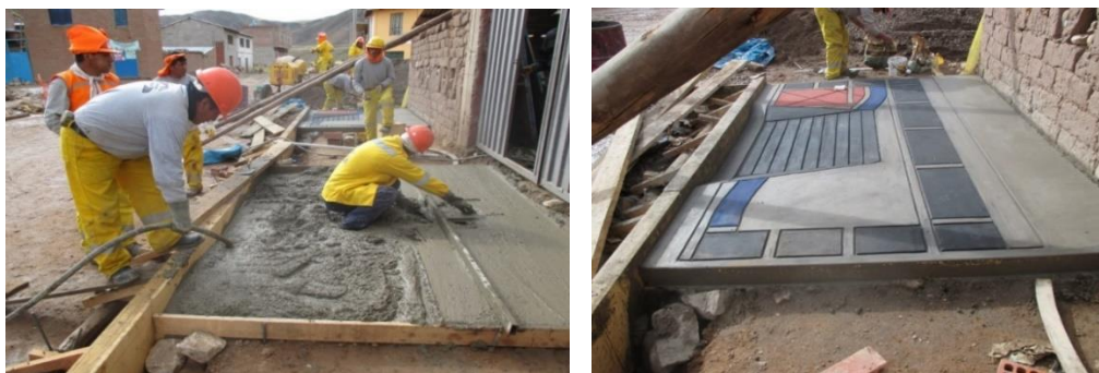
Figura 48 : Vaciado y acabado de veredas
