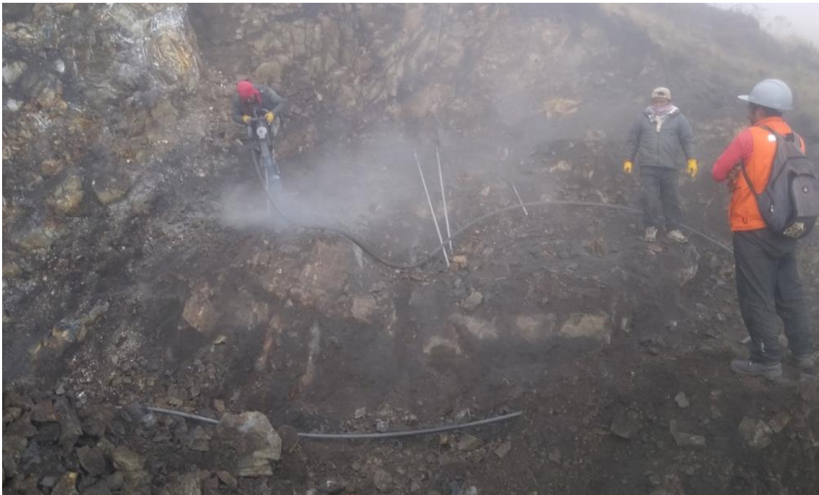
Foto 7 PERFORACION DE ROCA FIJA EN VOLADURAS
