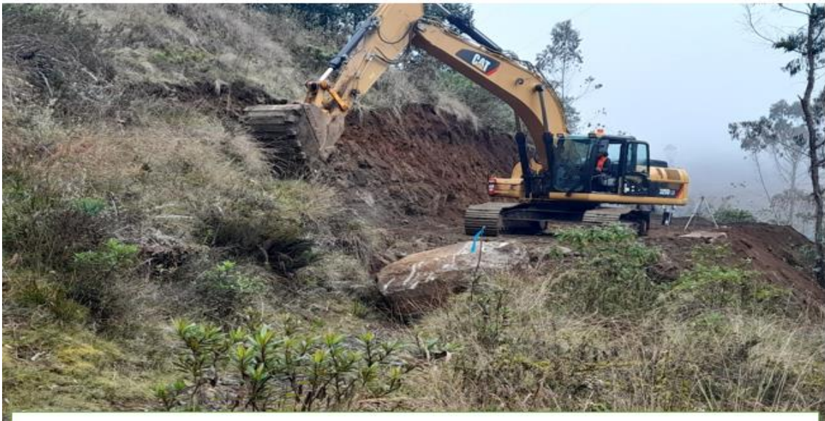
Foto 5 CORTE EN TERRENO DE MATERIAL SUELTO
