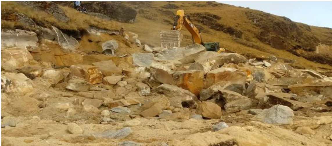
Foto 6 CORTE EN TERRENO DE ROCA DURA
