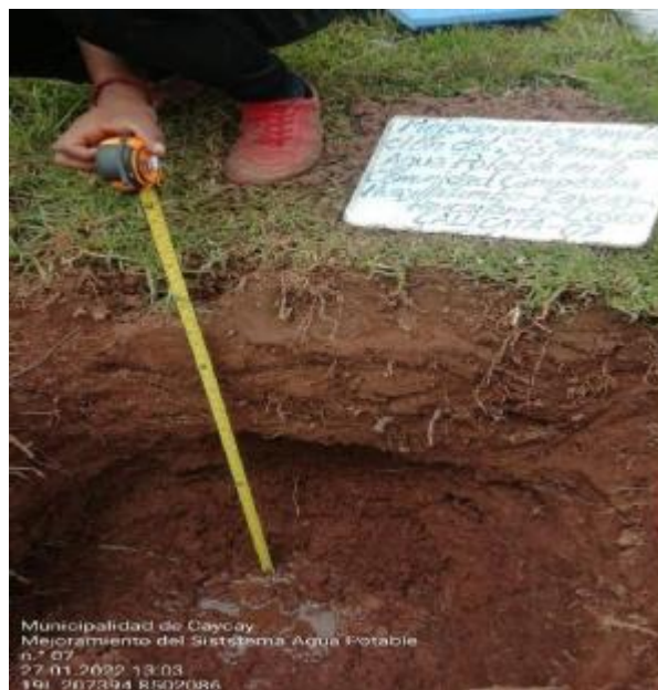
Figura 8: excavación de calicata C7
