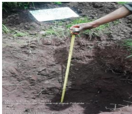
Figura 4: excavación de calicata C3
