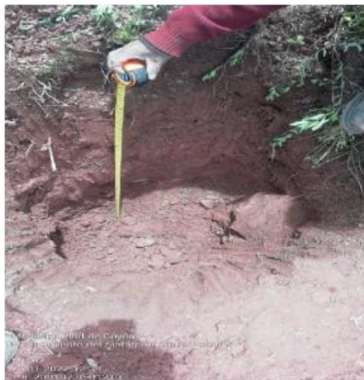
Figura 3: excavación de calicata C2
