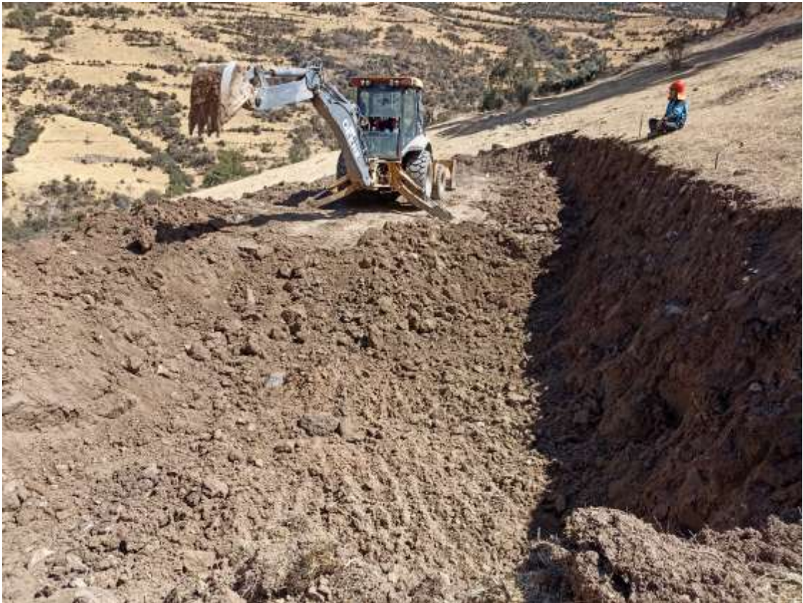
Figura 21. Uso de Retroexcavadora en la habilitación de PTAR.
