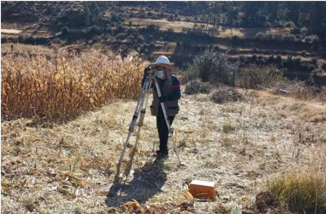
Figura 19. Control topográfico con Nivel de Ingeniero.
