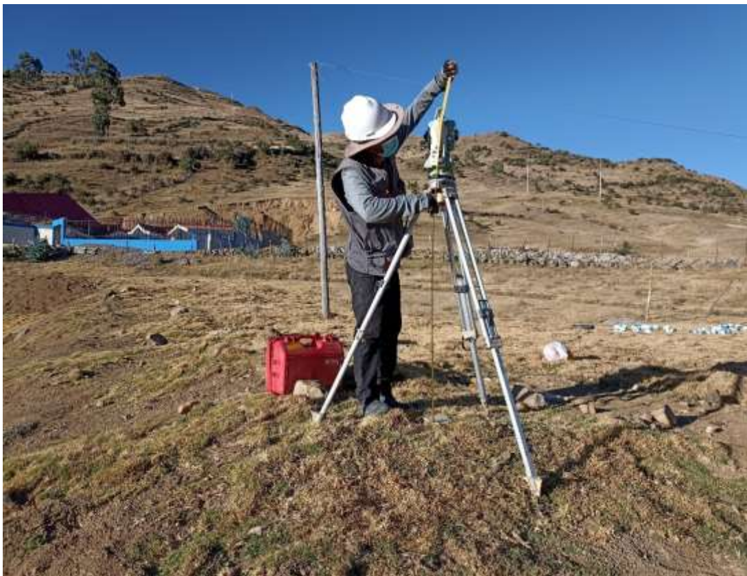
Figura 18. Levantamiento topográfico para replanteo con Estación Total.
