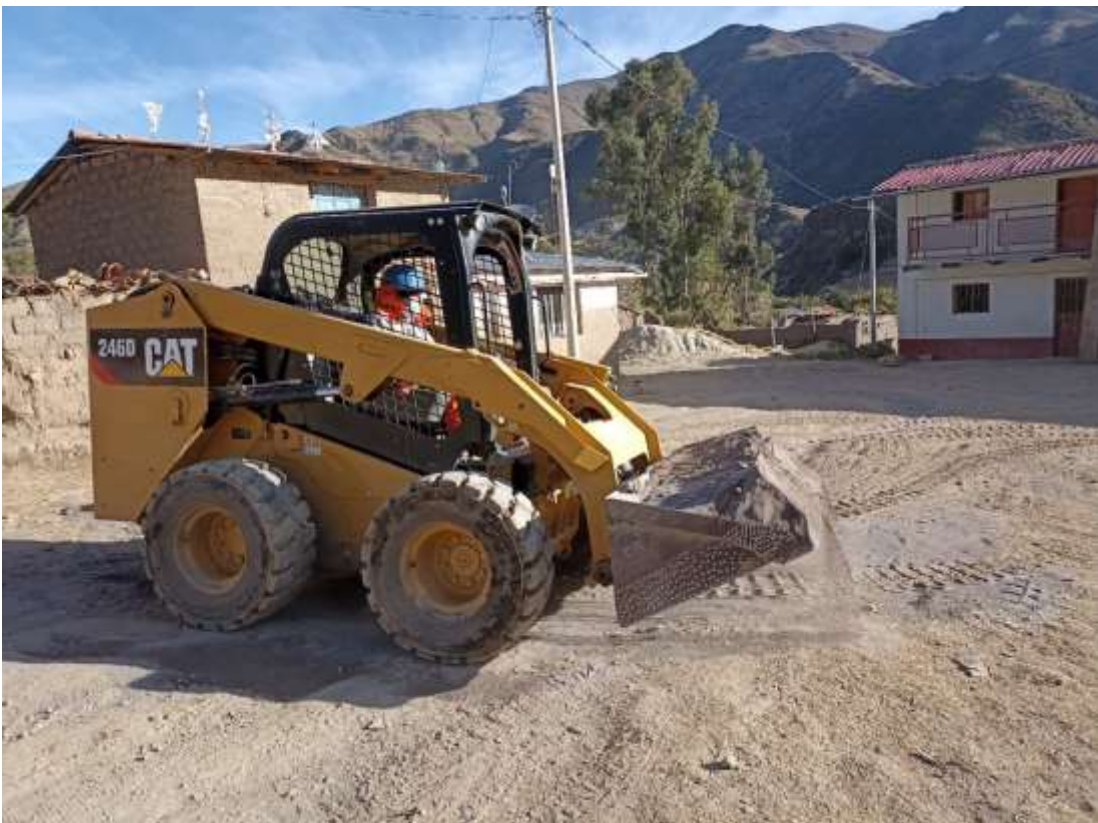
Figura 20. Uso de Bobcat para el traslado de material.
