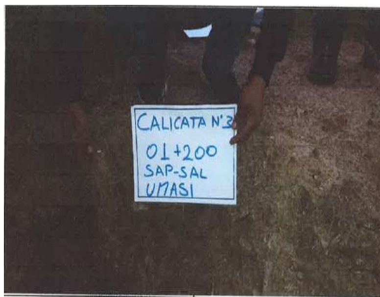
Figura 32. Se observa la excavación de Calicata.
