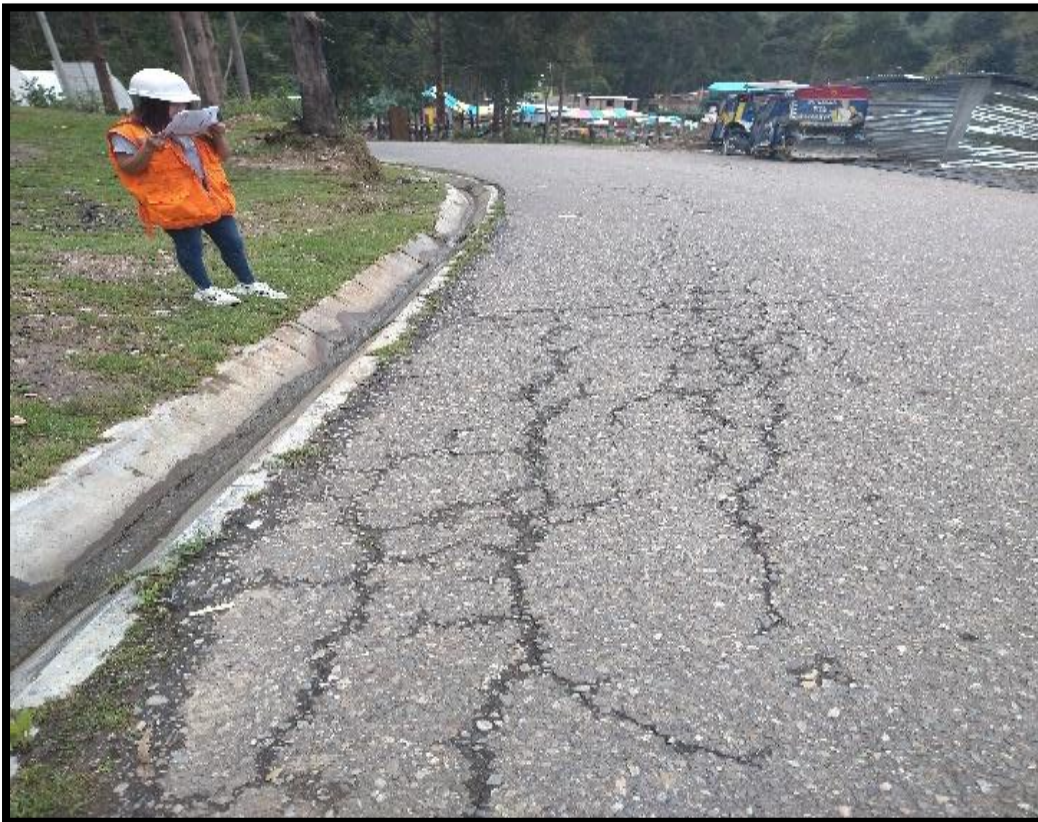
Foto 7. Se observa que se está realizando la evaluación del pavimento por el método de PCI.
