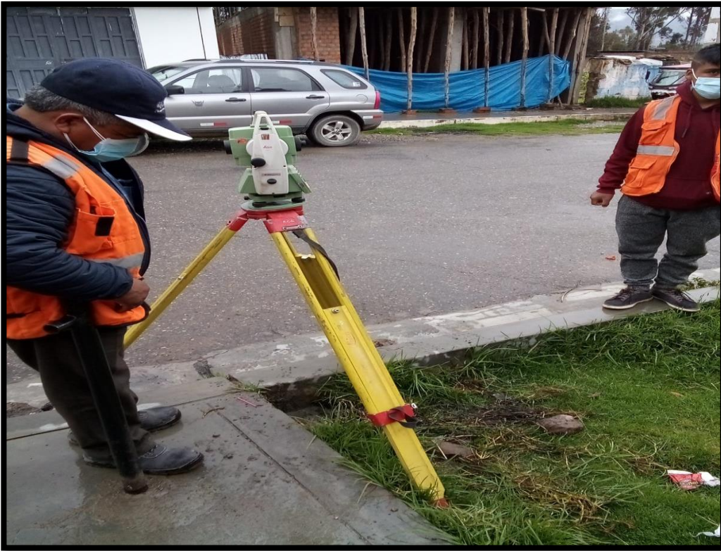
Foto 14. Se observa la imagen el posicionamiento de la estación total.
