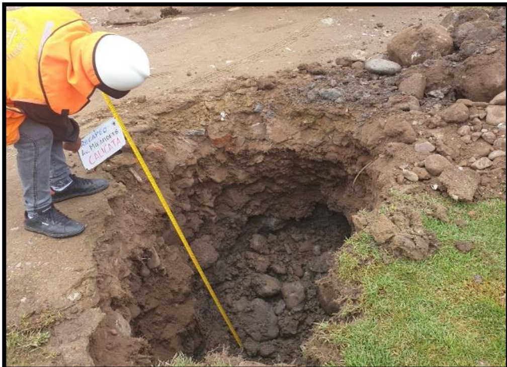
Foto 4. Se en la fotografía se observa la medición de la profundidad de la calicata y a su vez se puede observar que contiene bolonería.
