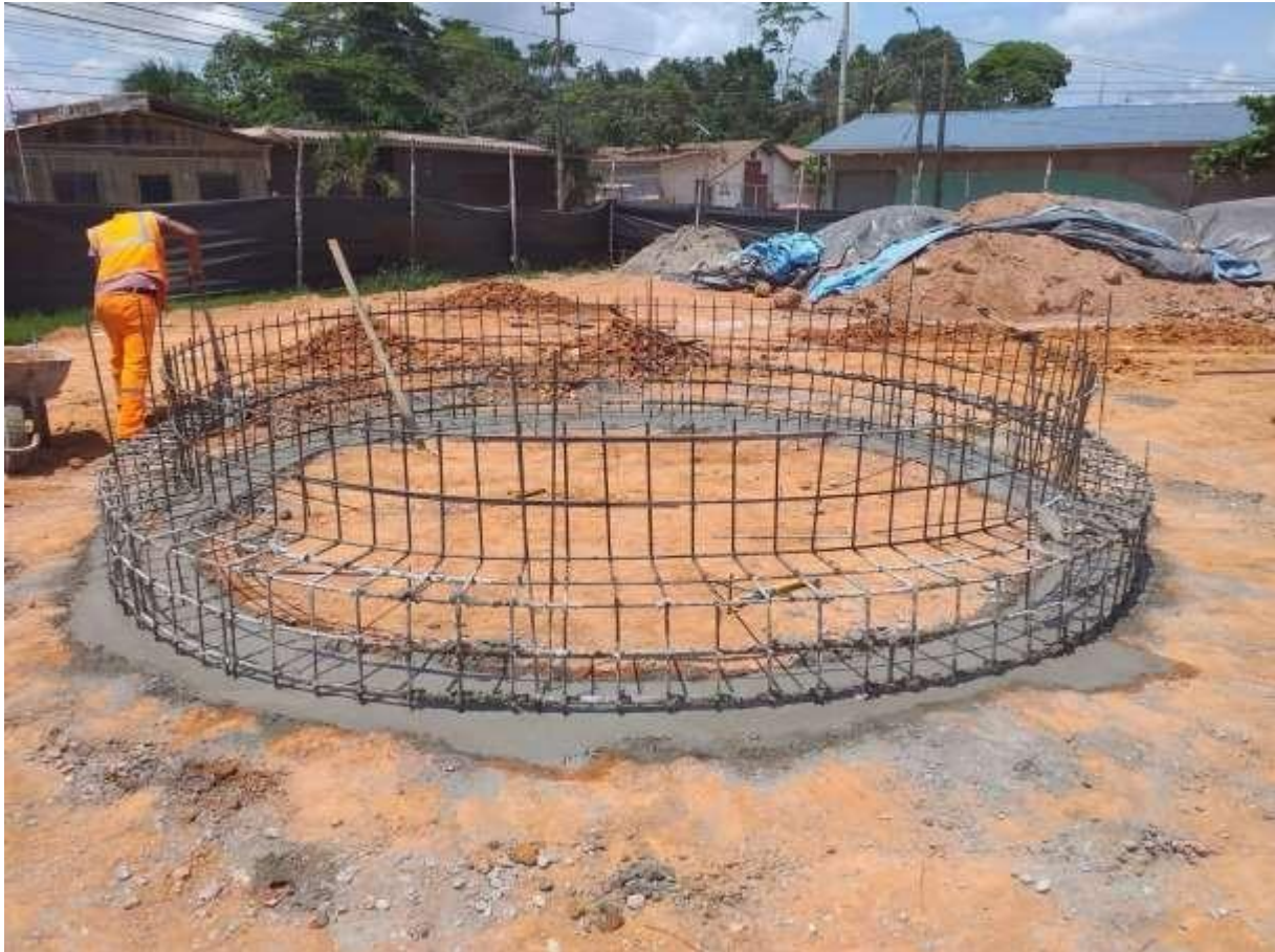
Foto 34: Armado de acero
