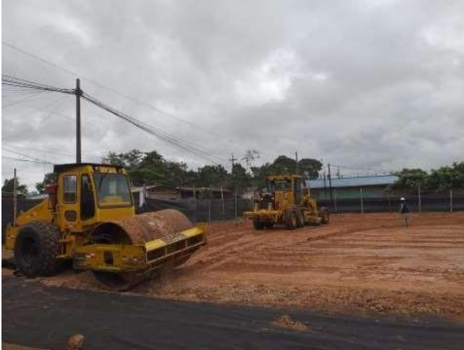
Foto 15: corte y nivelado e= 0.20 cm
