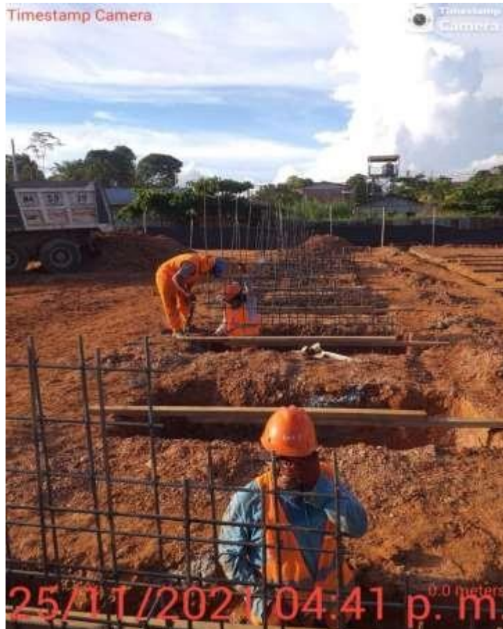
Foto 28: Armado de acero
