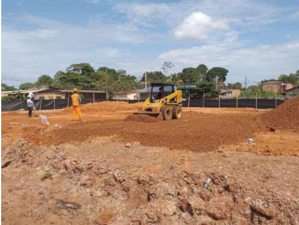
Foto 18: riego y nivelación e=0.10 cm
