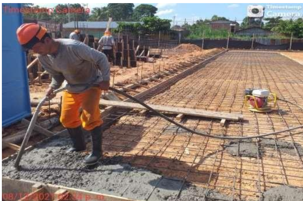
Foto 23: vibrado de concreto
