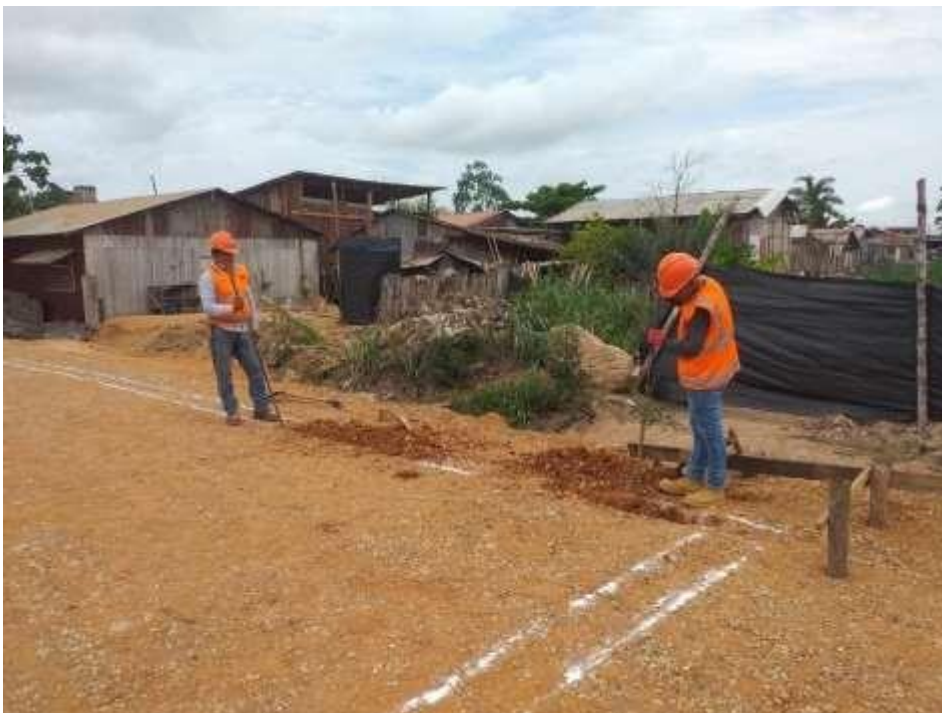
Foto 19: excavación de uñas de losa
