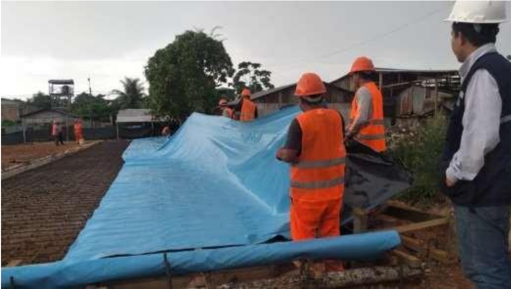
Foto 20: parrilla de losa deportiva
