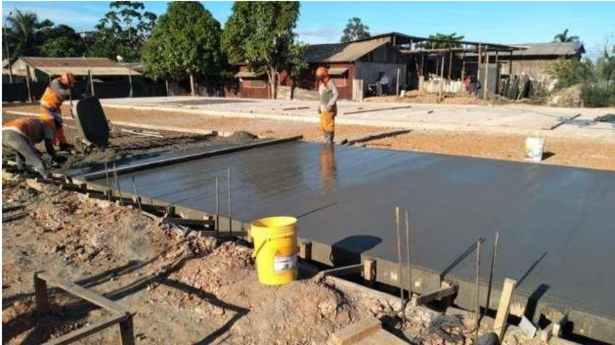
Foto 25: vibrado de concreto
