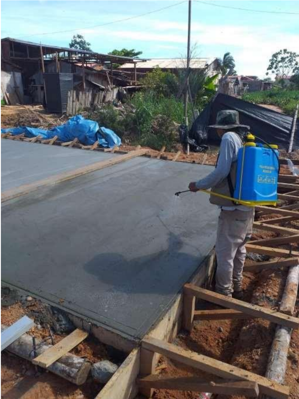
Foto 26: curado de concreto
