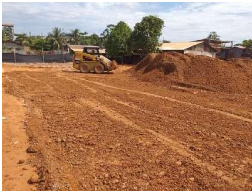
Foto 16: riego de la base granular 70/30
