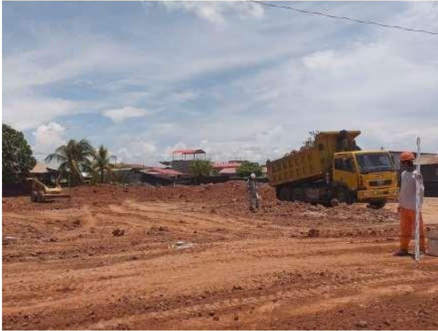
Foto 10-: relleno con material de préstamo
