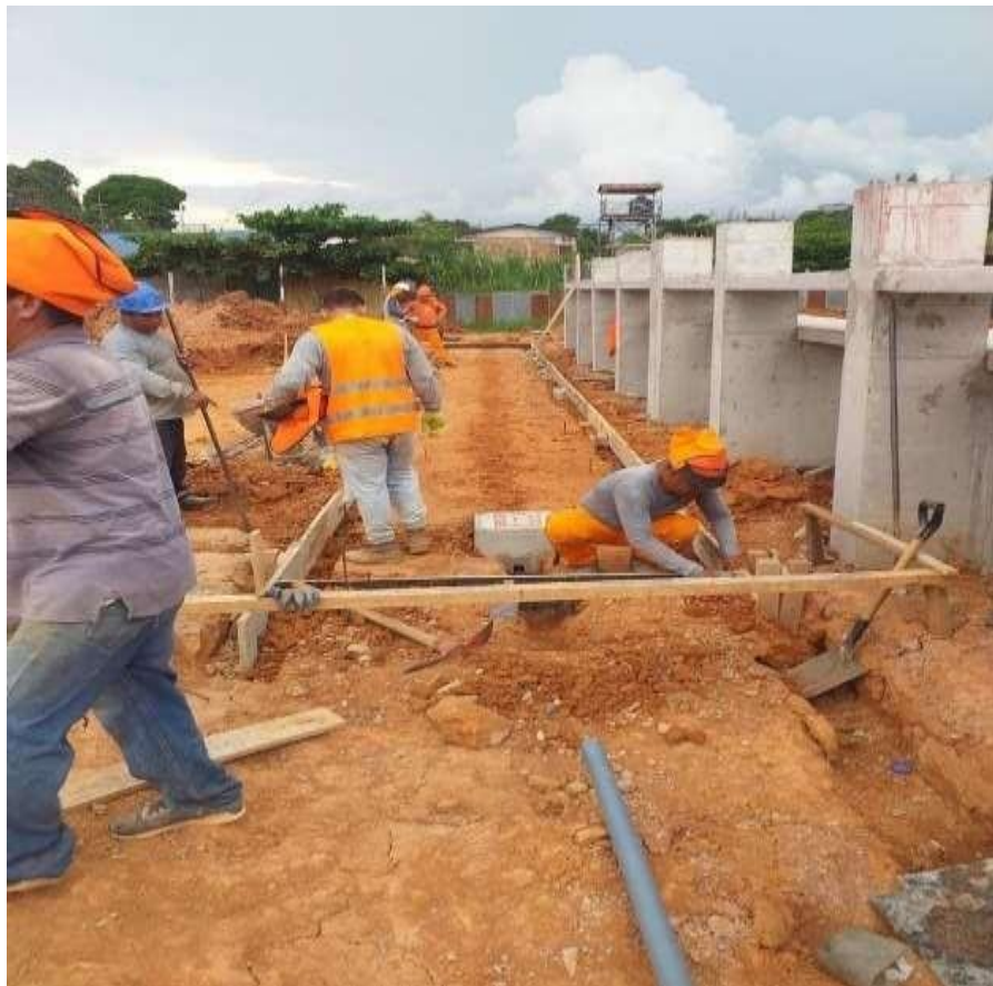
Foto 39: encofrado de veredas
