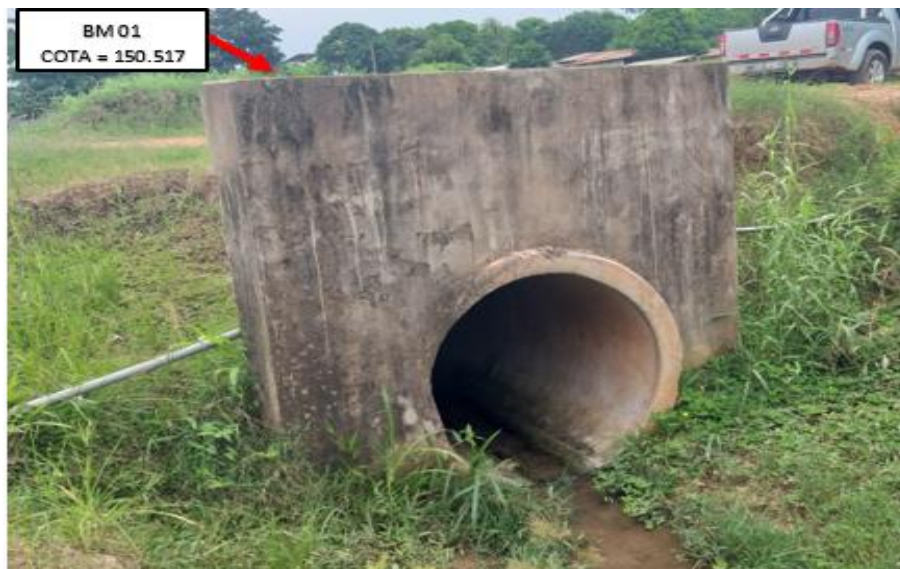
BM1 UBICADO EN LA LOZA SUPERIOR DE LA ALCANTARILLA
