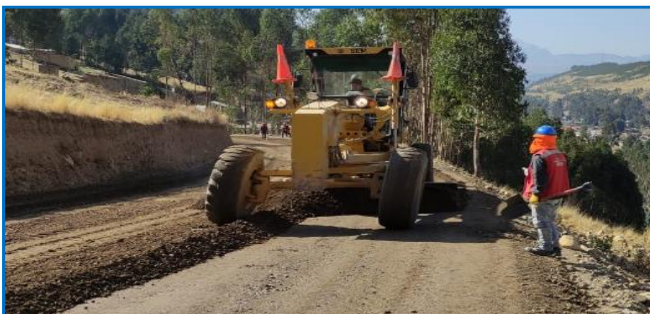
Foto 12 Imagen de trabajos iniciales
