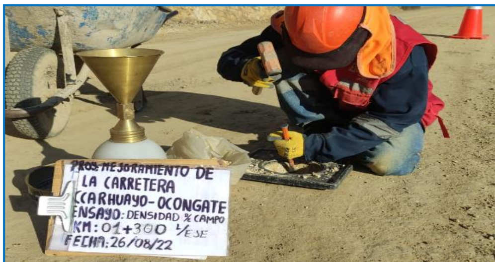
Foto 11 Imagen de trabajos en obra
