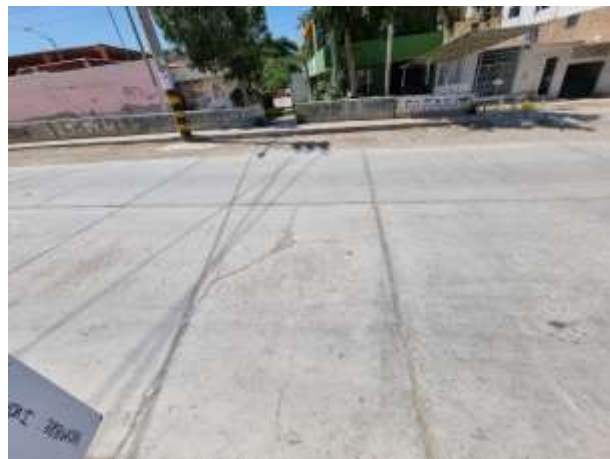
Figura N° 64: Pavimento rígido de zonas aledañas Fuente: Propia, 2022.
