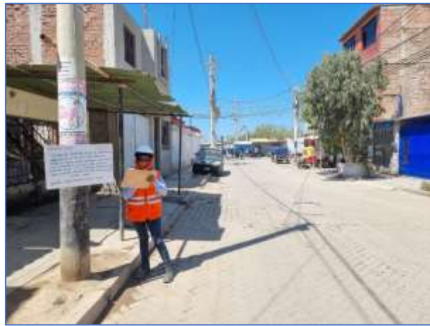
Figura N° 63: Tramo final que conecta con carretera Panamericana Fuente: Propia, 2022.
