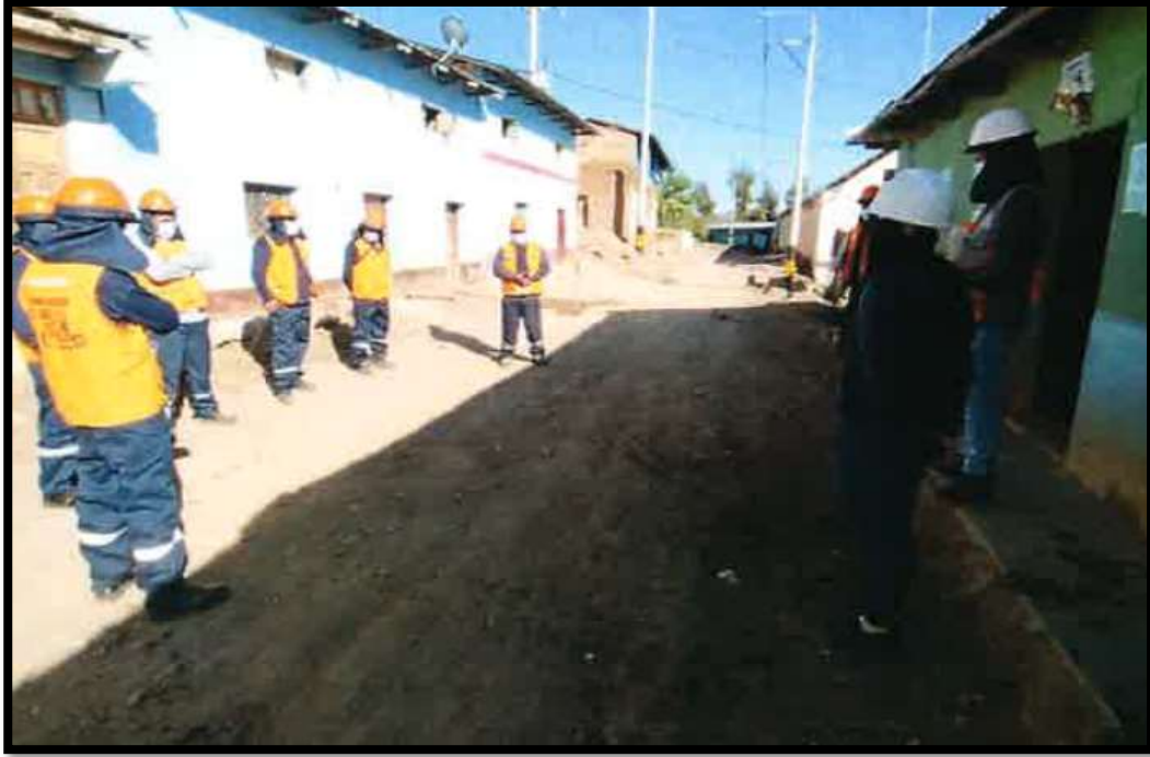
FOTO N° 5 Charla de seguridad antes de iniciar las labores
