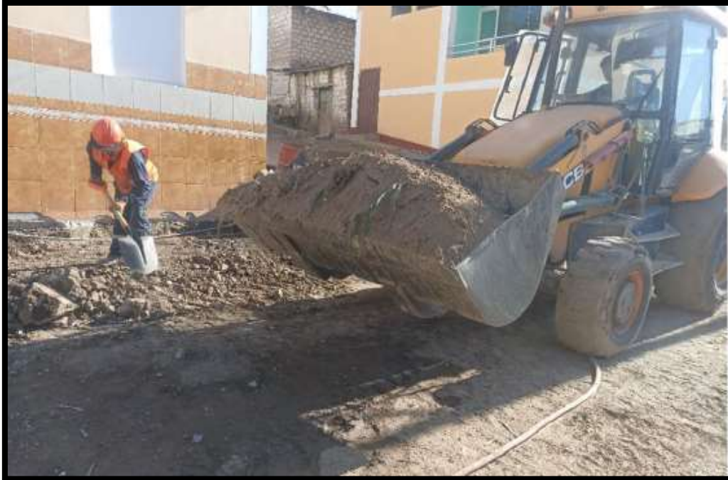
FOTO N° 3 Limpieza y eliminación de material excedente
