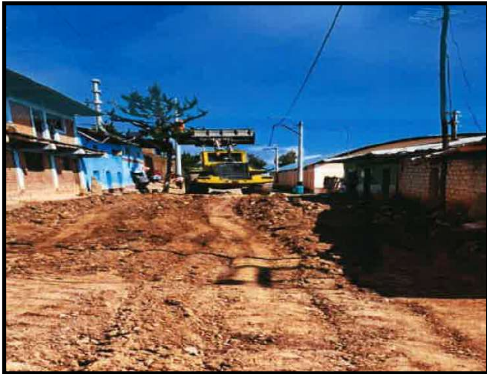
FOTO N° 2 Limpieza del área a intervenir
