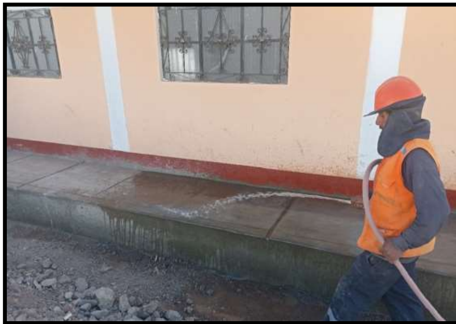
Foto N° 25: Colocación de juntas asfálticas
