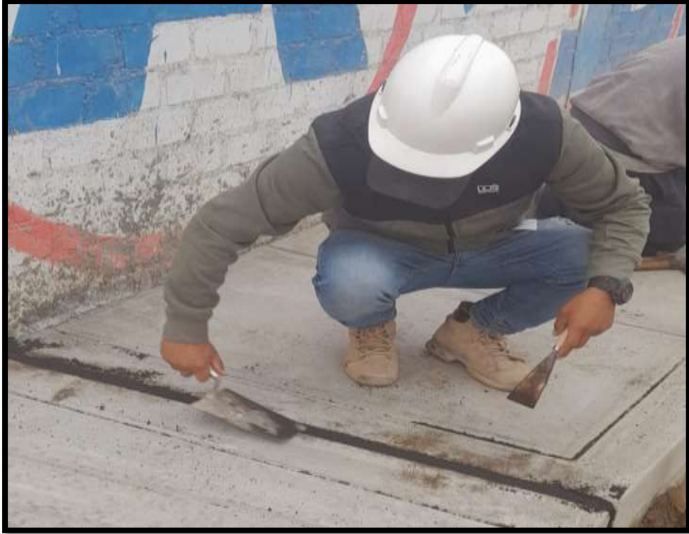
FOTO N° 12 Colocación de juntas asfálticas
