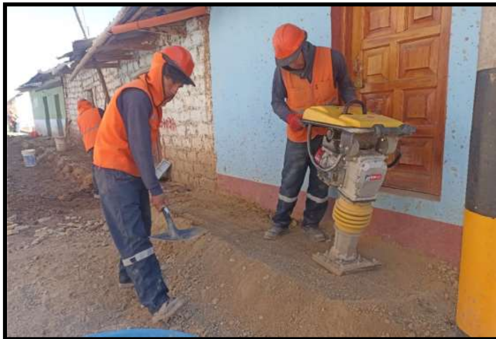
FOTO N° 8 Compactado del material de préstamo con apisonador
