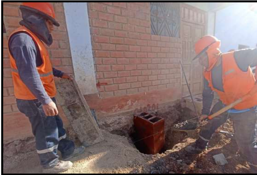
FOTO N° 6 Instalación de cajas de registro
