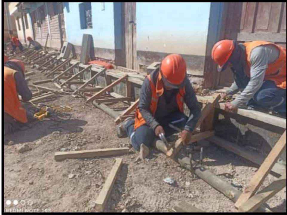
FOTO N° 9 Encofrado del área a intervenir
