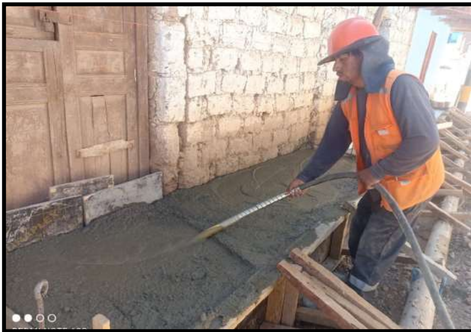
FOTO N° 10 Vaciado y vibración del concreto
