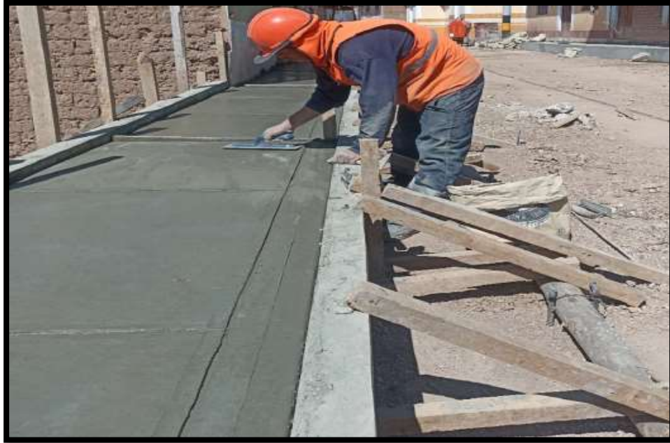
FOTO N° 11 Tarrajeo y semi pulido de vereda
