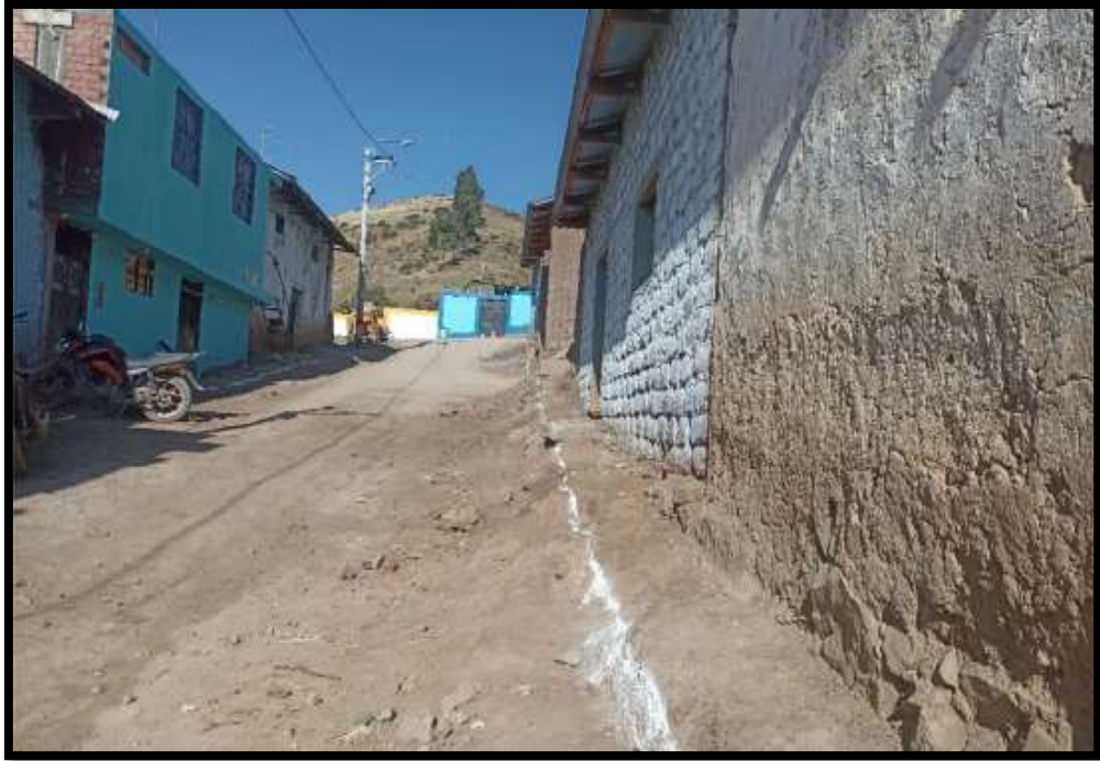
FOTO N° 1 Trazo y replanteo para la limpieza del área a intervenir
