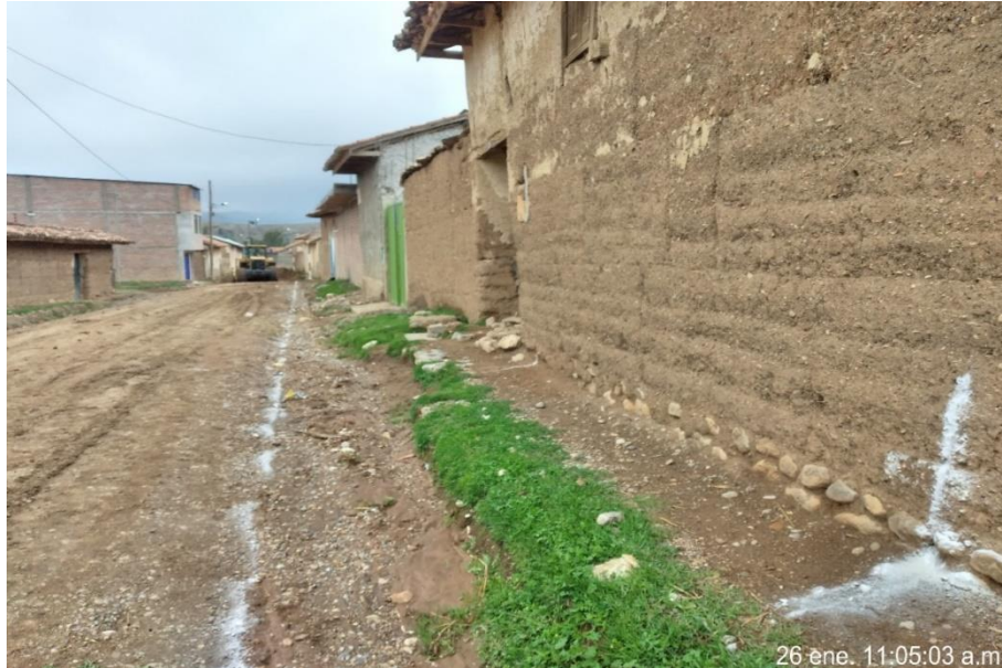
IMAGEN N° 12: Trazo en Obra
