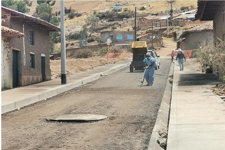
IMAGEN N° 26: Ensayo de Densidad del Suelo de la Base
