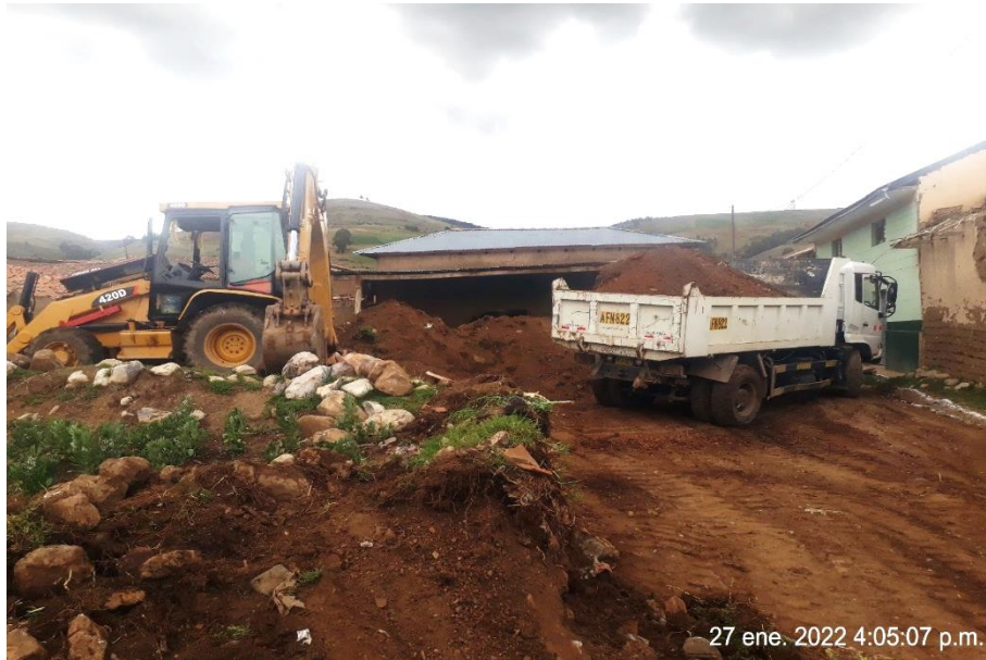
IMAGEN N° 14: Eliminación de Material Excedente
