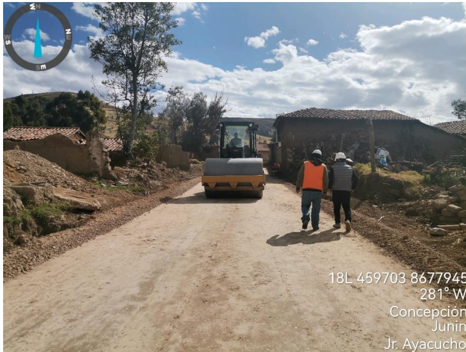
IMAGEN N° 24: Compactación de la Base
