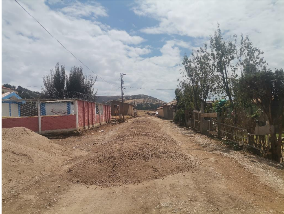
IMAGEN N° 19: Tendido de Material Granular para Sub Base
