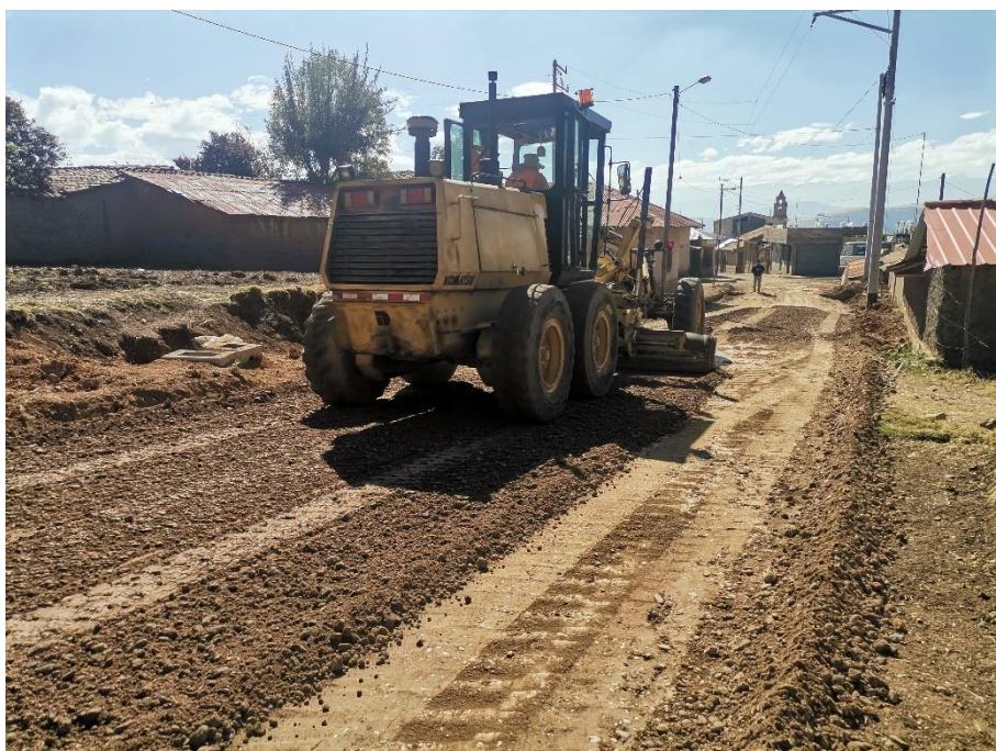
IMAGEN N° 19: Tendido de Material Granular para Sub Base
