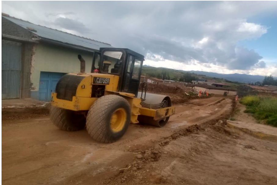
IMAGEN N° 16: Compactado de la Subrasante
