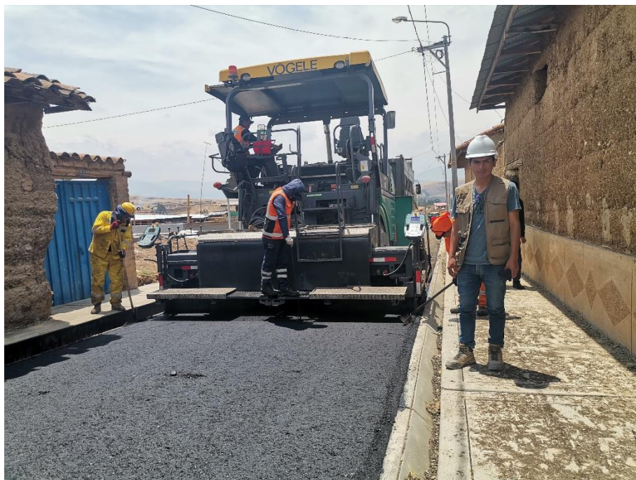
IMAGEN N° 29: Colocado del Asfalto con la Pavimentadora
