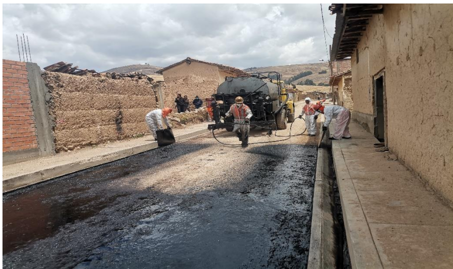
IMAGEN N° 27: Imprimación con Asfalto MC-30
