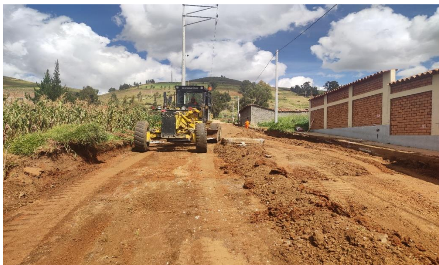
IMAGEN N° 15: Escarificado de la Subrasante
