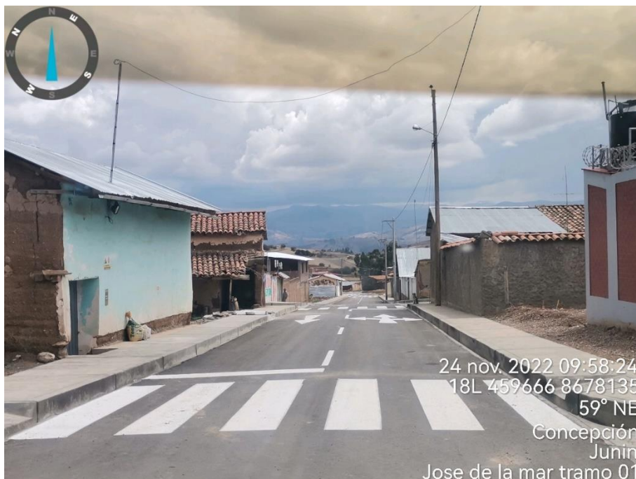
IMAGEN N° 31: Compactado del Asfalto
