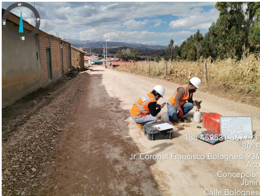
IMAGEN N° 25: Ensayo de Densidad del Suelo de la Base
