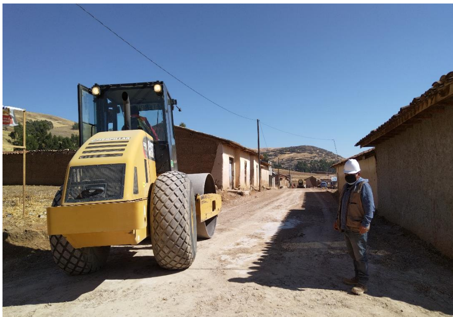
IMAGEN N° 21: Compactado de la Sub Base
