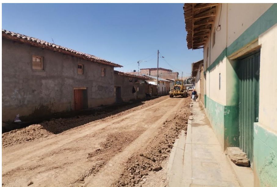
IMAGEN N° 23: Tendido de Material Granular para Base
