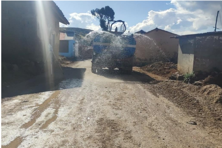
IMAGEN N° 20: Riego del Material Granular
