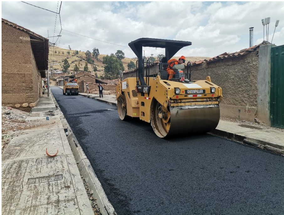
IMAGEN N° 30: Compactado del Asfalto
