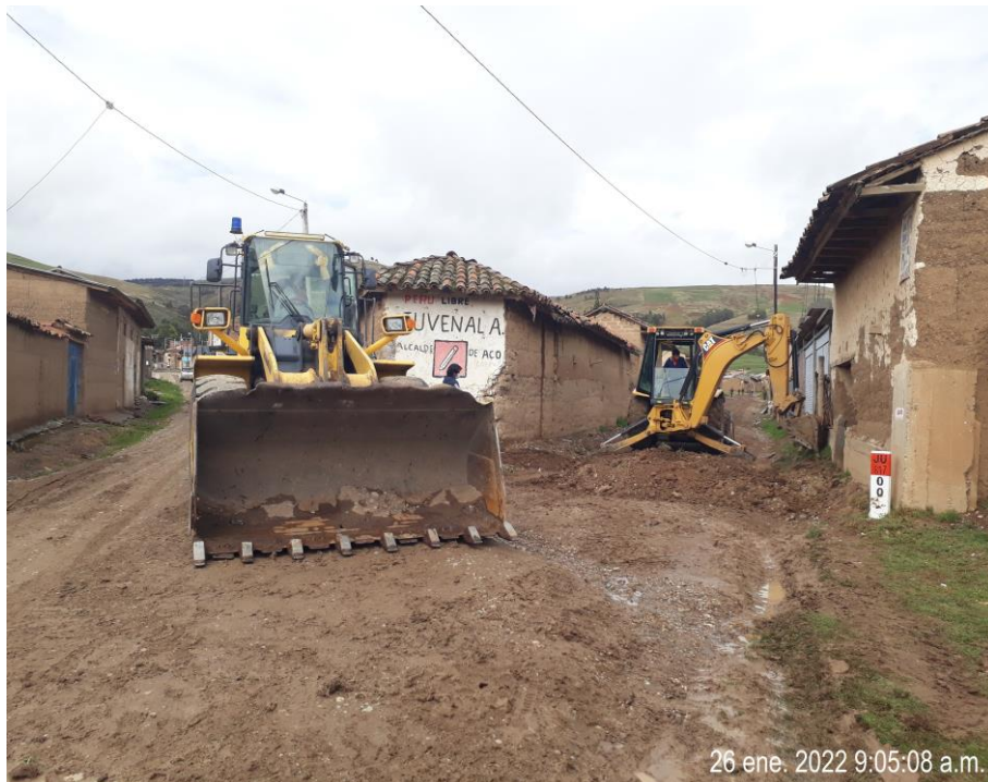
IMAGEN N° 13: Movimiento de tierra con Maquinarias
