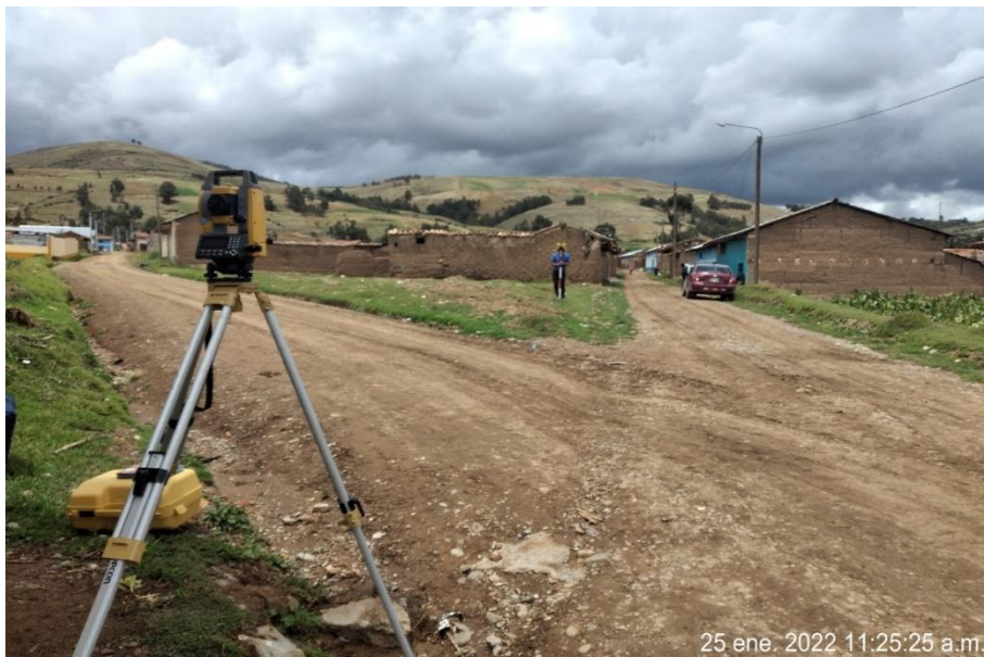
IMAGEN N° 11: Trabajos de Replanteo
