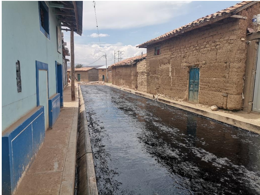
IMAGEN N° 28: Imprimación con Asfalto MC-30
