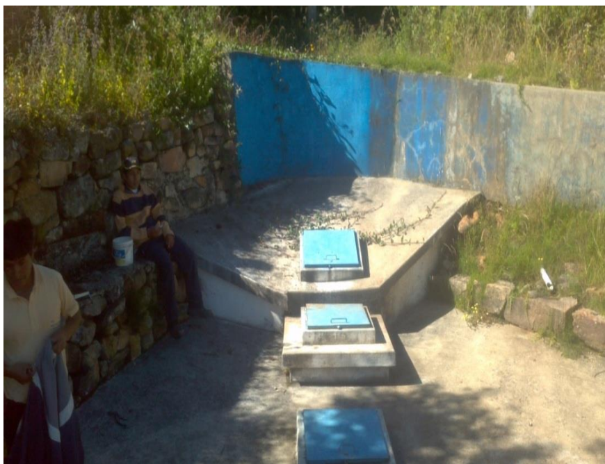
Foto N° 01 Vista de a captación “Santa Rosa”
