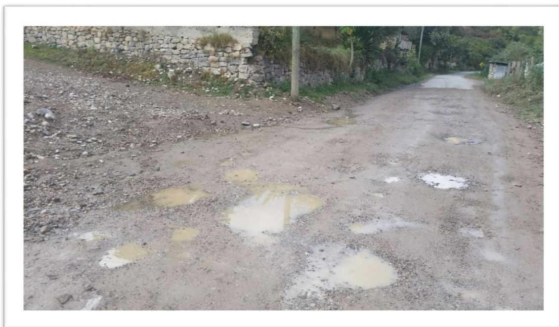
Figura 13. Estado de la vía a ejecutar
