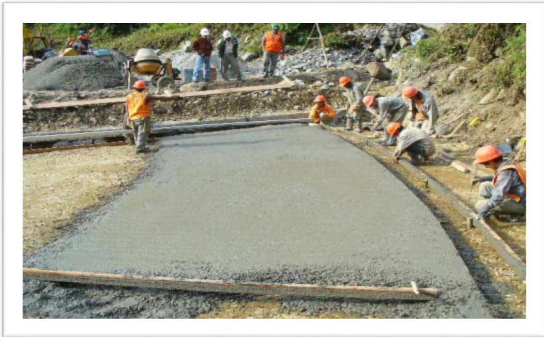
Figura 18. Trabajos del Baden en obra
