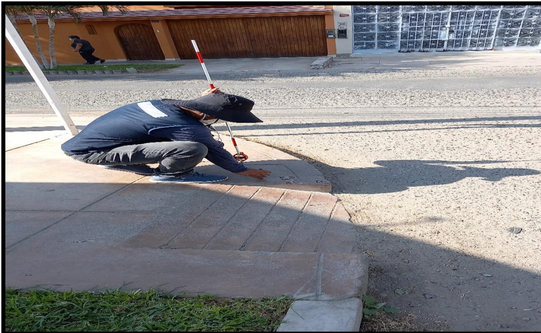
COLOCACIÓN DE BM PARA REPLANTEO EN CAMPO
