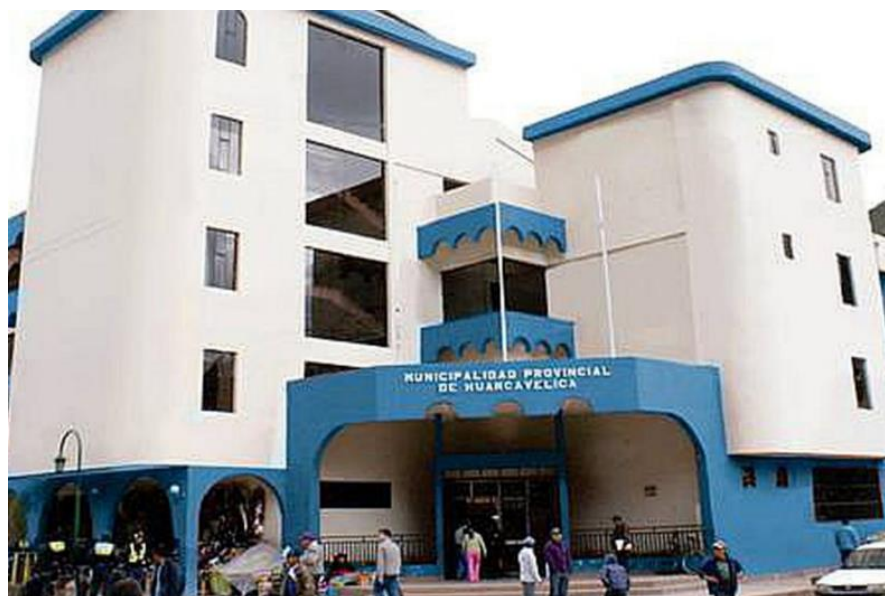
figura 1 Municipalidad Provincial de Huancavelica
