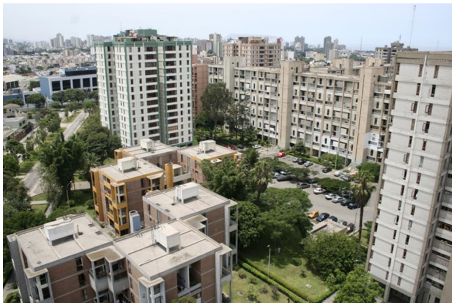
Figura 16. Vista Aérea baja – Residencial San Felipe
