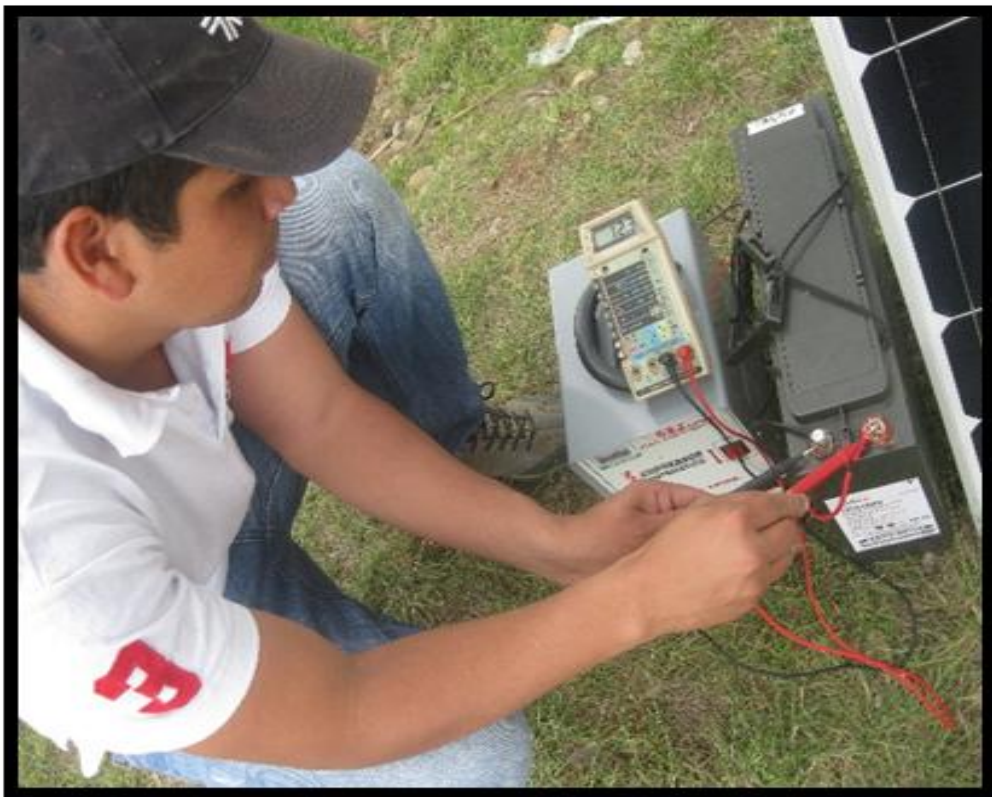
Foto N° 2: Realizando pruebas con la batería gelificada
