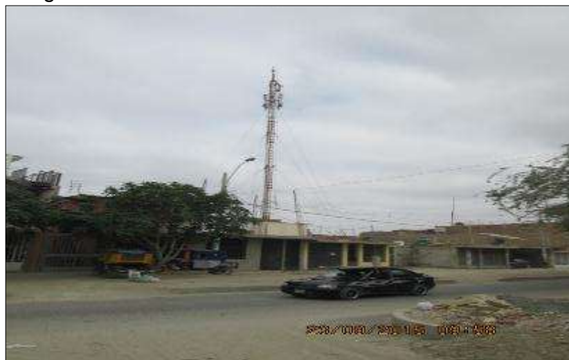
Imagen N° 10: Tránsito de vehículos cerca a las antenas
