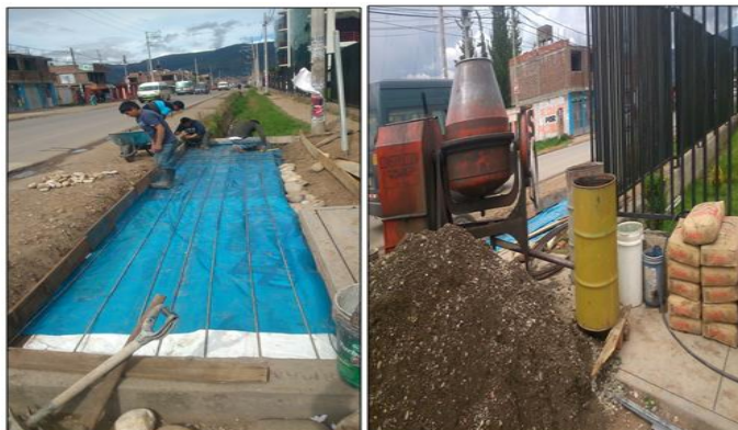
FIGURA 3: 2 construcción de la plataforma del paradero
