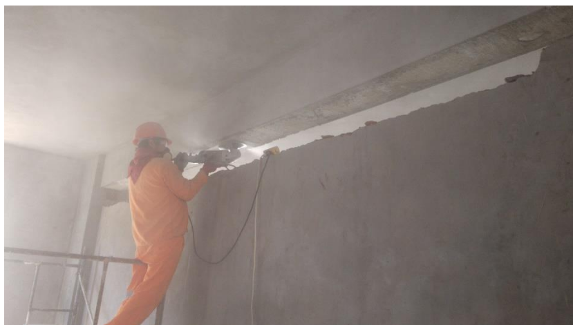
Figura 21 Puliendo la cara inferior de la viga
