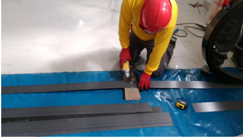
Figura 30 Aplicando el aditivo epóxico en la cara que se va a adherir en la viga
