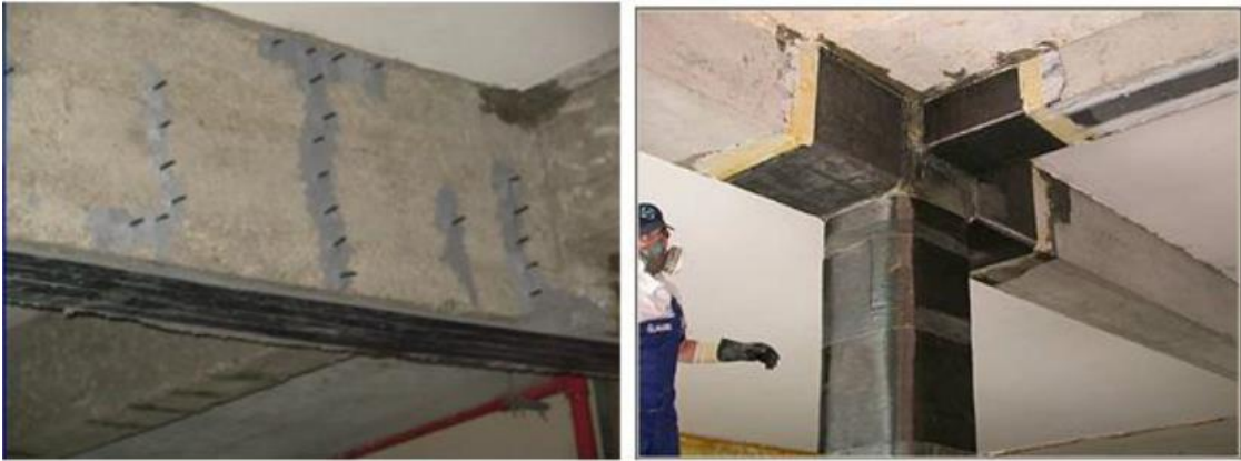
Figura 5 Colocación de refuerzos multicapa
