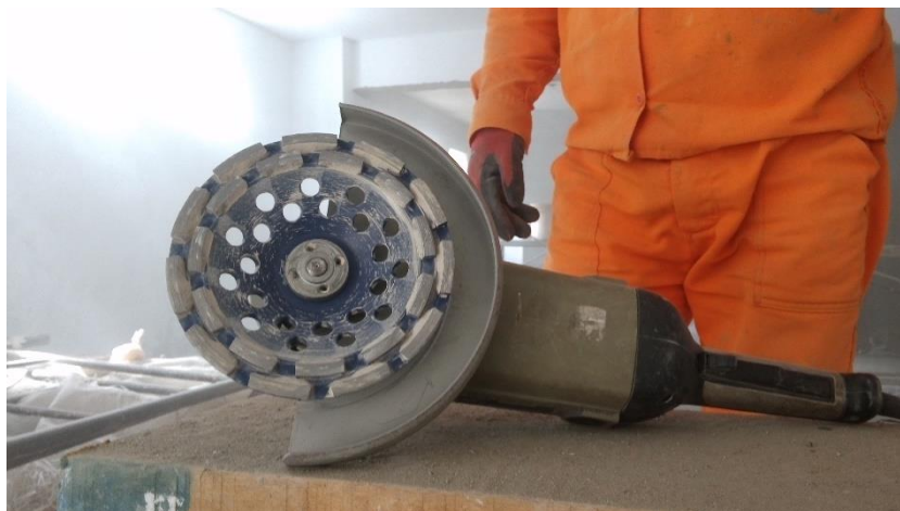
Figura 17 Disco de corte de concreto (Para dar la forma de entramado)
