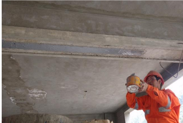
Figura 35 Se aplicara el epóxico sikadur 32 para adherir el mortero del tarrajeo sobre la fibra de carbono
