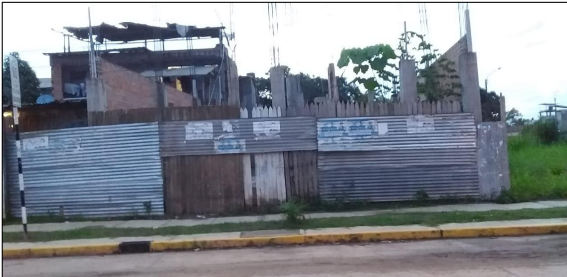
Fotografía 02: Vivienda donde se implementó los residuos sólidos de construcción (Jr. Zavala)
