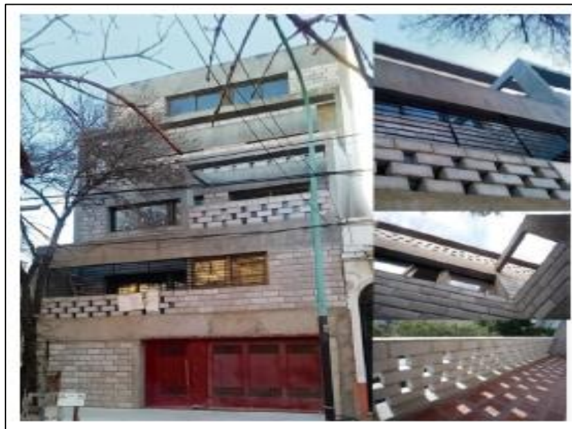
Figura 9: Exteriores y balcones.
