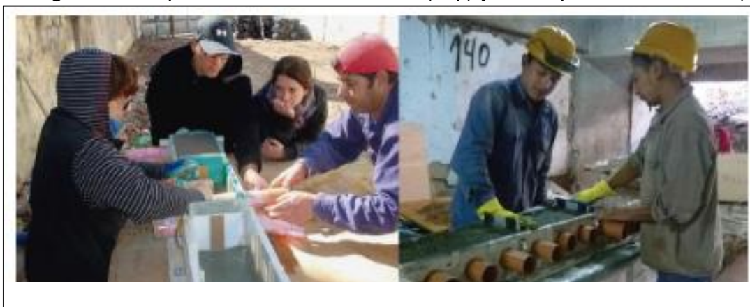
Figura 10: Capacitación en obra: inicial (izq.) y en etapa de fabricación (der.).
