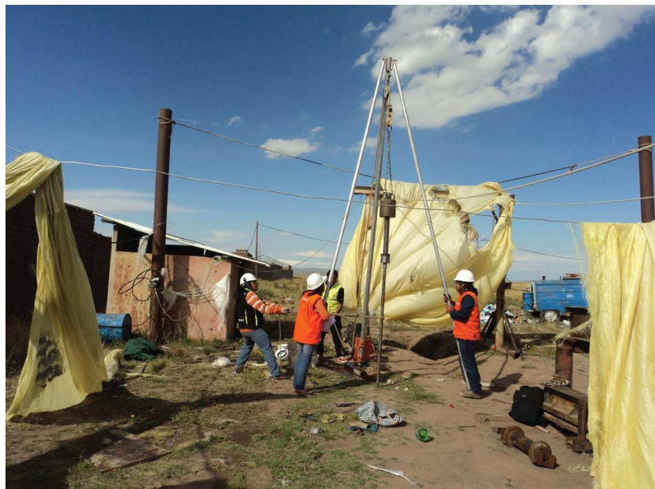
Imagen 1 Ensayo de Penetración Estándar (SPT)
