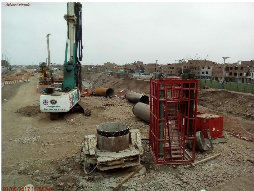
FIGURA 21: PERFORACIÓN PILOTE CIRCULAR
