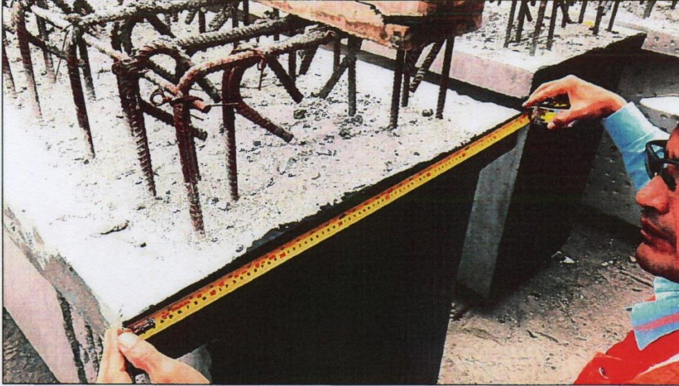
Dimensiones de sección de viga conformes
