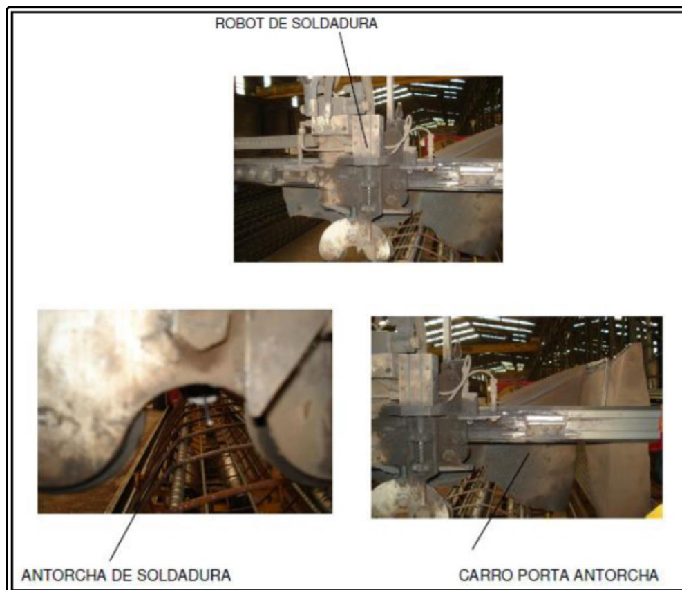
FIGURA 37: ROBOT DE SOLDADURA.
