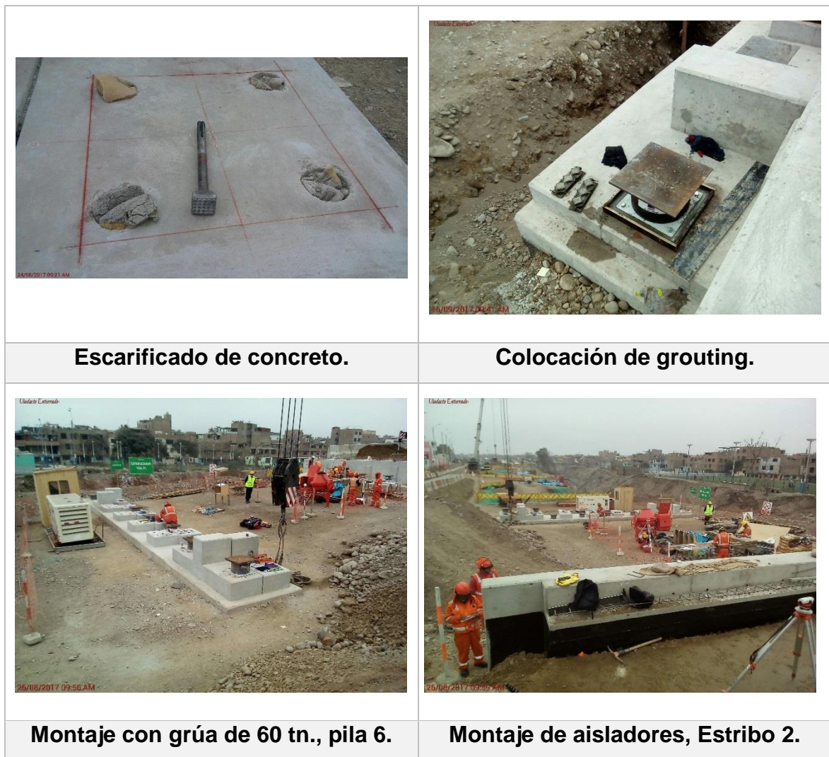
FIGURA 84: FOTOS: COLOCACIÓN DE GROUTING.
