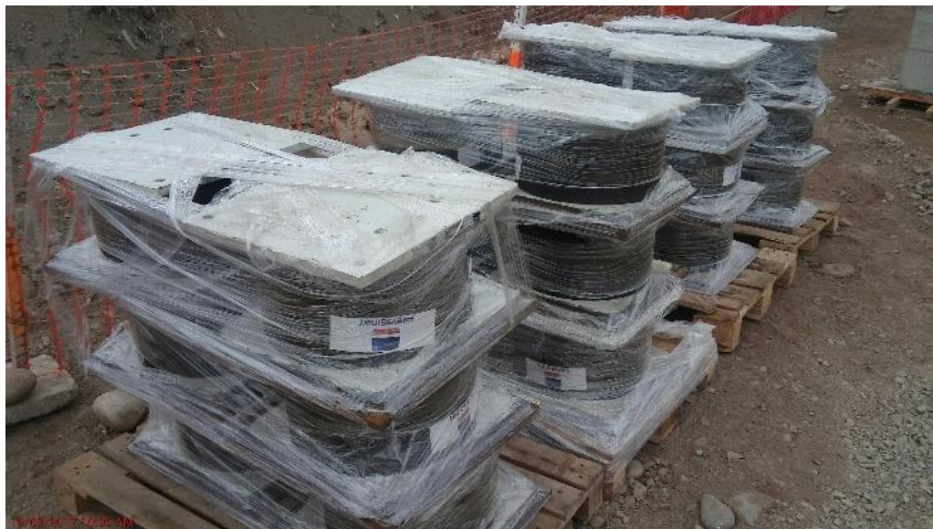
FIGURA 79: TRANSPORTE E IZAJE MECÁNICO DE LOS AISLADORES.
