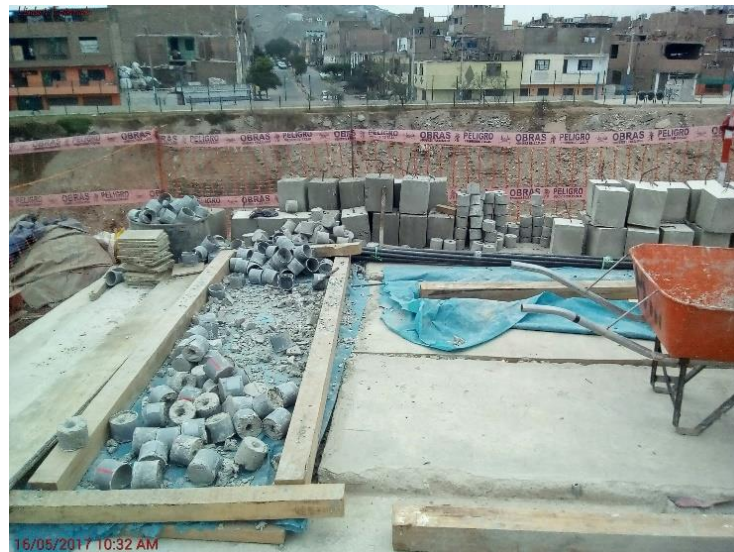
FIGURA 25: ESPACIADORES DE CONCRETO
