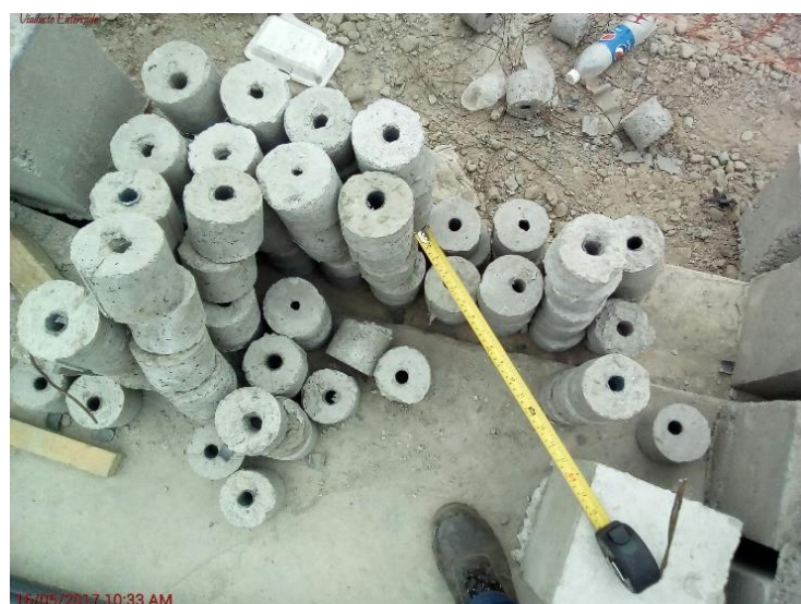
FIGURA 26: DADO DE CONCRETO
