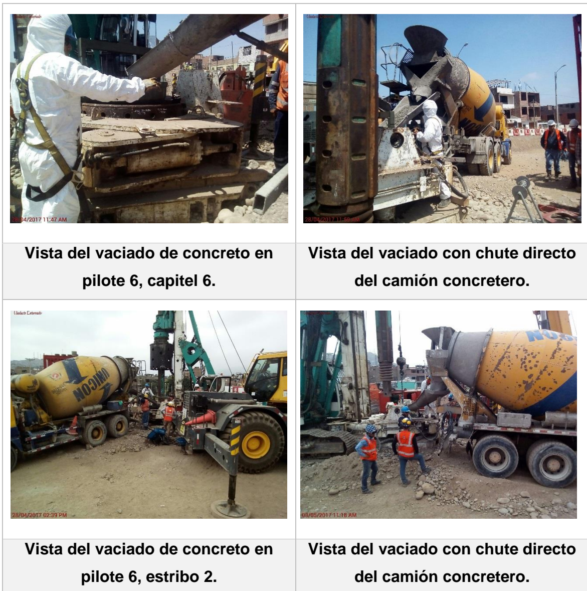
FIGURA 44: FOTOS: VACIADO DE CONCRETO
