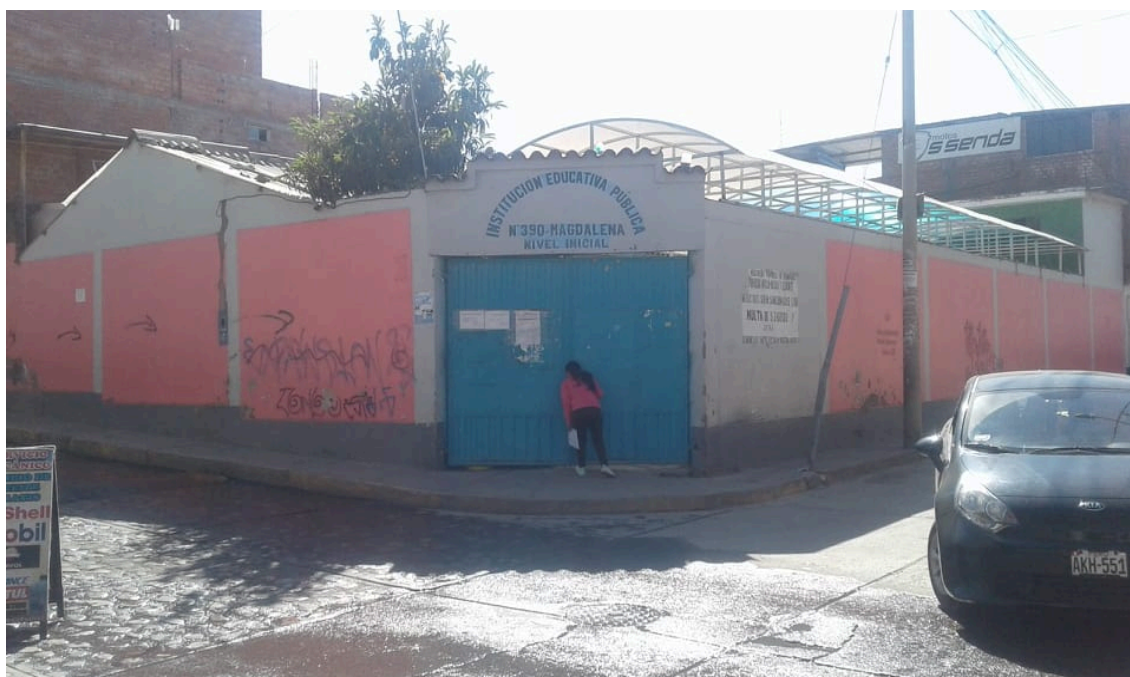
Figura N° 1. Entrada principal de la Institución Educativa Inicial N° 390 “Magdalena”, distrito de Ayacucho, provincia de Huamanga, departamento de Ayacucho; donde se realizó la investigación.
