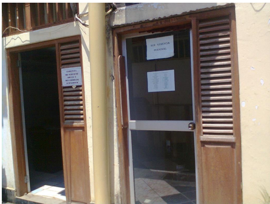
Oficinas de la Municipalidad de Tambopata
