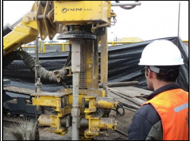
Supervisión presente en la perforación
