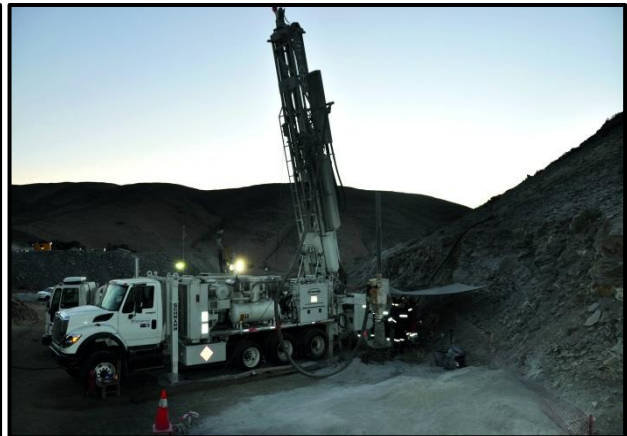
Inspección diaria en la perforación
