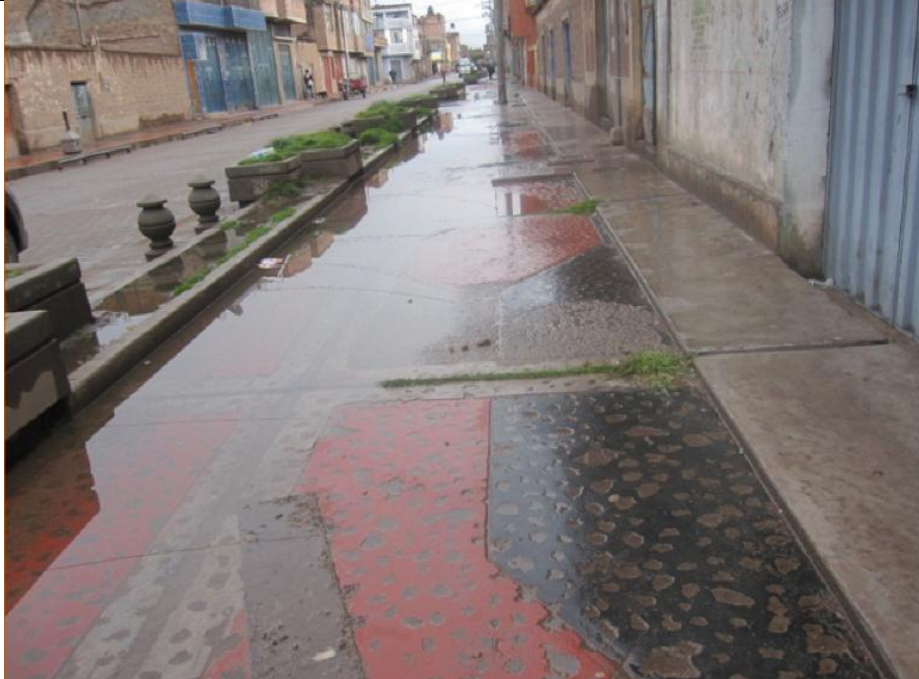
FOTOGRAFÍA N° 9: Se observa la deficiencia de pendientes lo que ocasiona considerable estancamiento de agua. Jr. Nicolás Jarufe – Juliaca.
