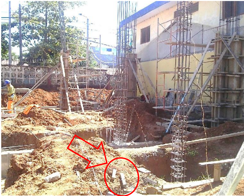
Figura 03. Se observa retazos de tablillas con presencia de clavos incrustados que deberán de extraer los clavos o doblados. Se deberá aplicar el programa de orden y limpieza.
