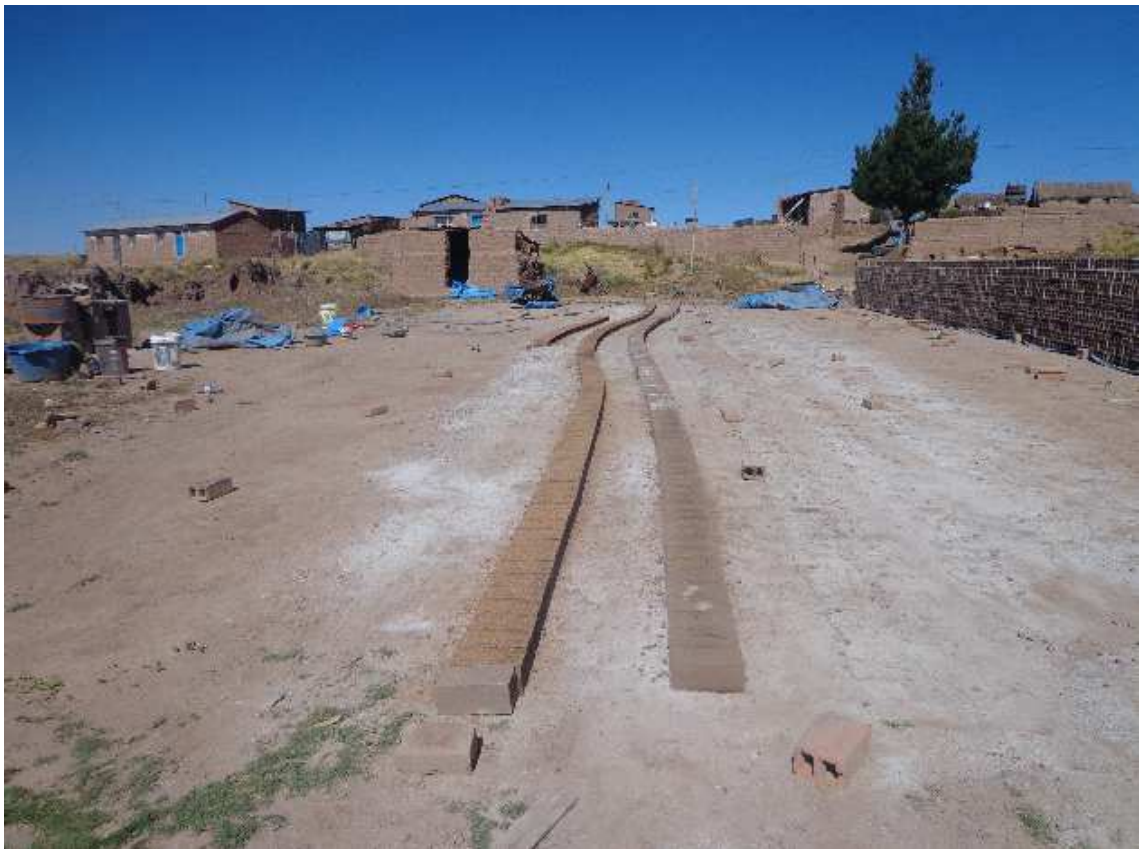
Figura 6.0: Secado de ladrillo crudo moldeado
