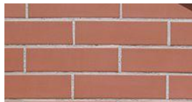
Imagen n°05 Ladrillo cara vista
