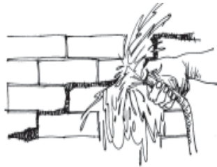
Imagen N°08 Lavado de juntas con chorro a presión.
