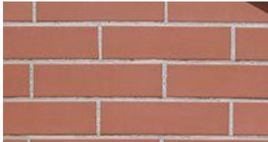
Imagen n°14 Ladrillo cara vista
