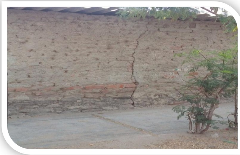
Imagen N°64 Muro agrietado por falta de confinamiento, en Calle San José Cuadra 1 Del Centro Poblado 19 De Agosto, Distrito La Unión – Piura
