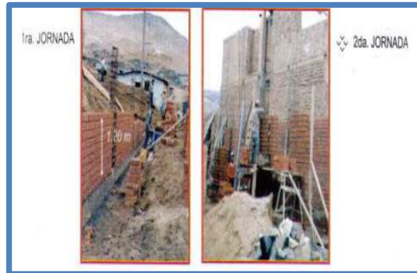
Imagen n°48 Construcción Diaria De Muro
