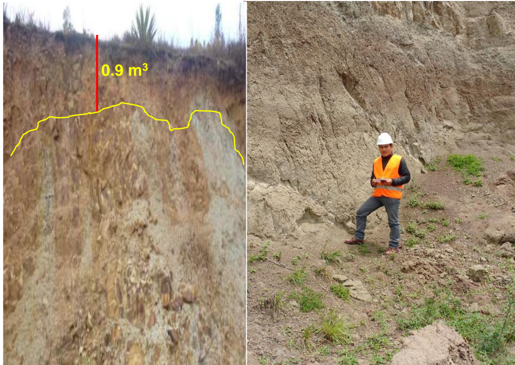
Figura 19: Cobertura a remover. Fuente: Elaboración propia. (2017).
