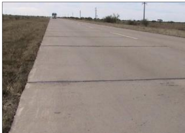
Imagen N° 30 Bombeo de Juntas
