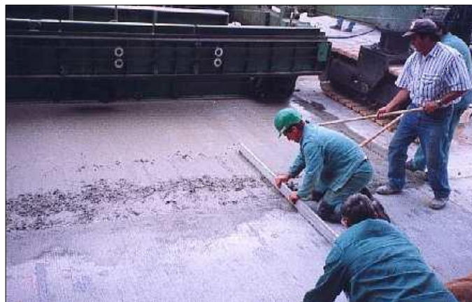
Imagen N° 04 Juntas de Construcción
