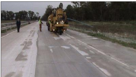
Imagen N° 21 Pulido del pavimento
