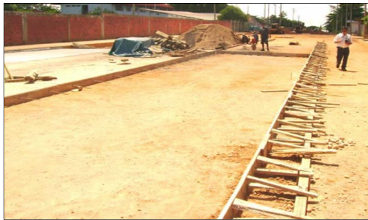
Imagen N° 04 Juntas de Dilatación
