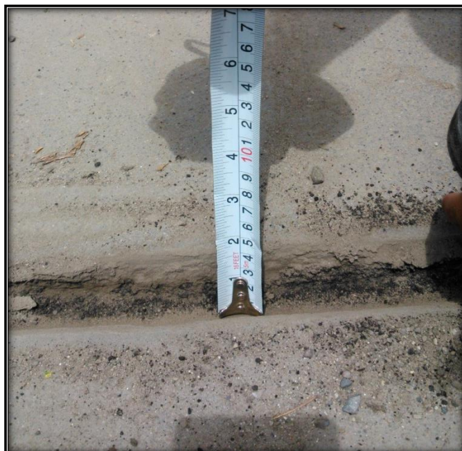
Imagen N° 54 Asentamiento de Mortero Asfáltico h=5 cm.
