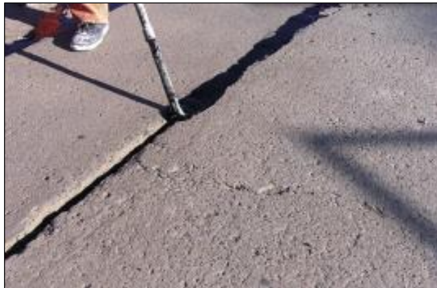
Imagen N°18 Sellado de Junta de Dilatación
