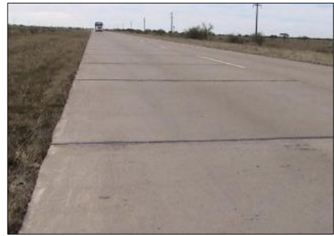
Imagen N°19 Bombeo de Juntas
