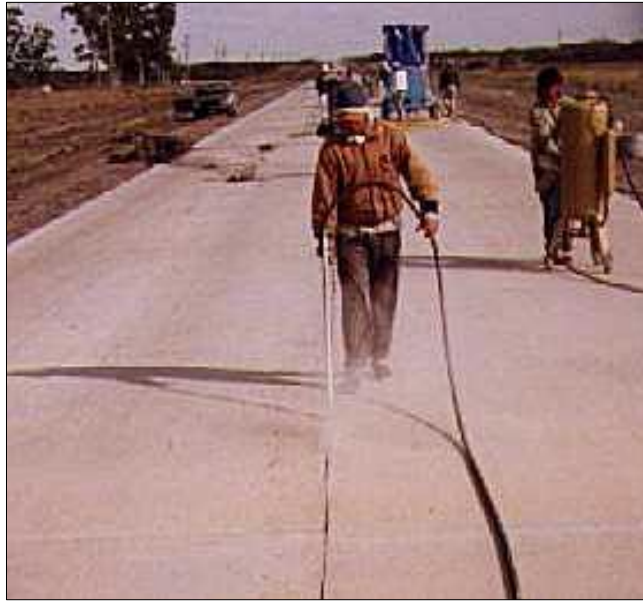
Imagen N° 28 Soplado de Juntas previo al sellado
