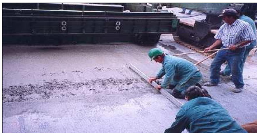
Imagen N° 07 Juntas de Construcción
