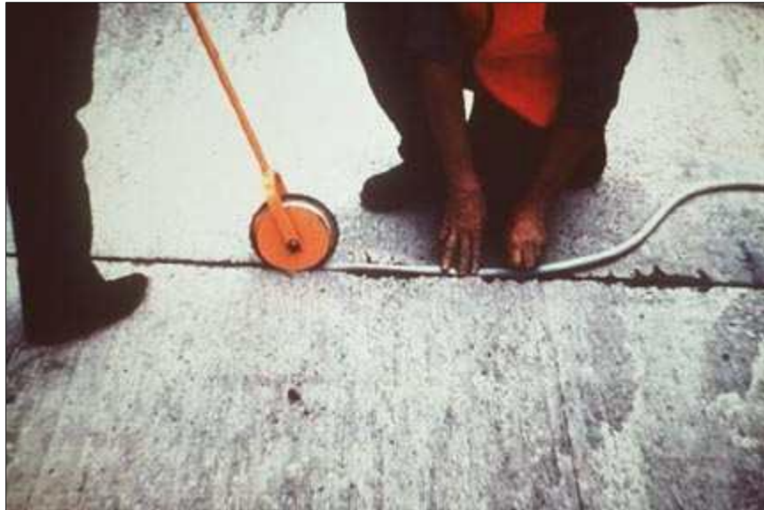
Imagen N° 29 Colocación de Material de sellado
