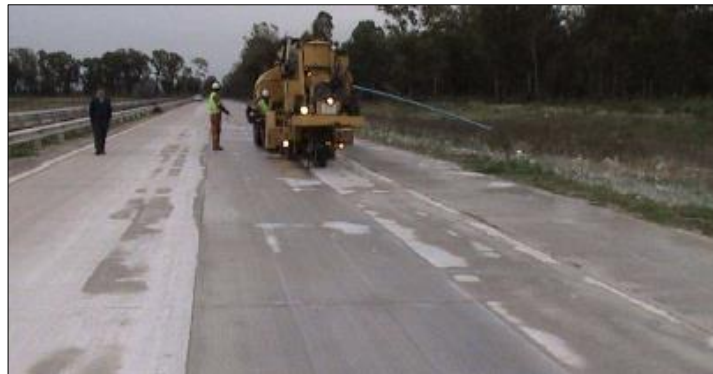
Imagen N° 21 Pulido del pavimento
