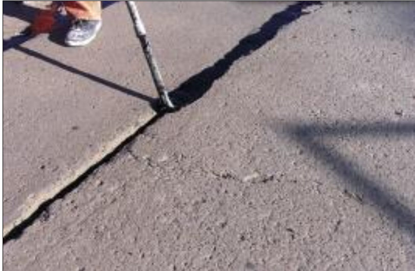
Imagen N°26 Sellado de Junta de Dilatación Fuente: Sellado de Fisuras y Relleno de Juntas Autor: Flexotop - Insumos Viales SA
