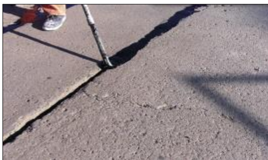
Imagen N°18 Sellado de Junta de Dilatación
