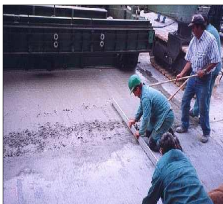
Imagen N° 04 Juntas de Construcción
