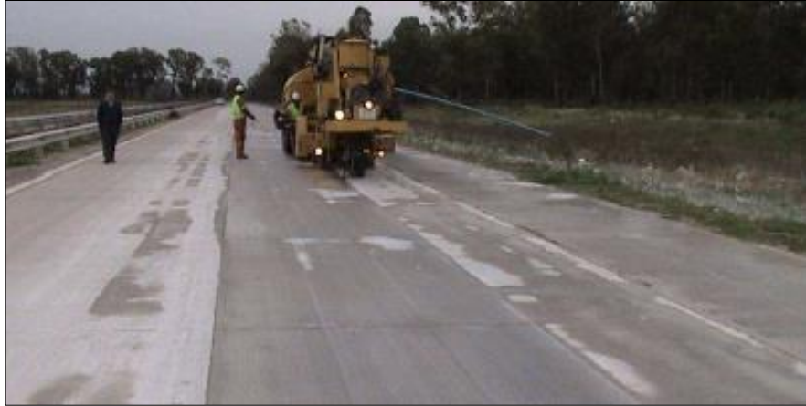
Imagen N° 32 Pulido del pavimento
