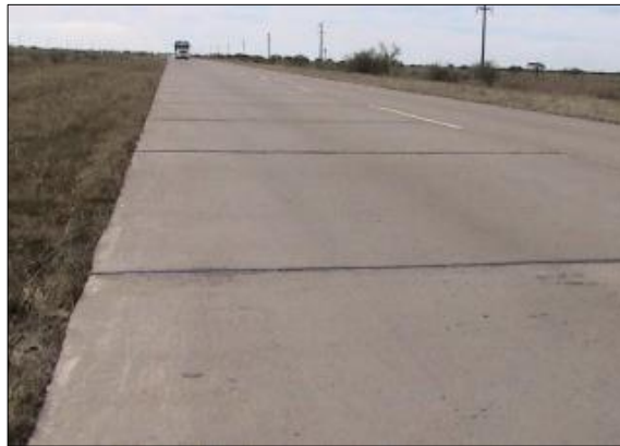
Imagen N° 19 Bombeo de Juntas
