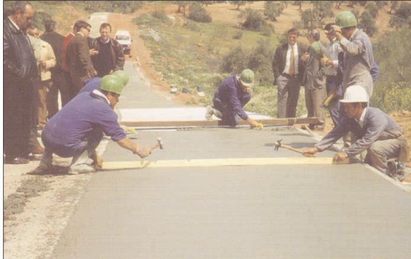
Imagen N° 02 Ejecución de Juntas en Fresco
