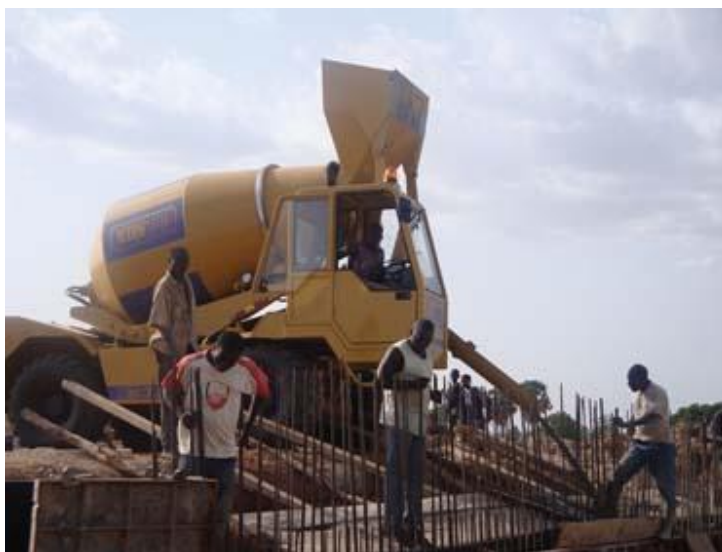
Figura N° 14: Operación de la Autohormigonera en Obra
