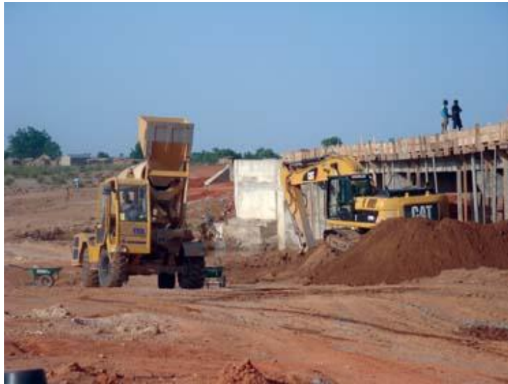
Figura N° 13: Desempeño de la Autohormigonera en Obra
