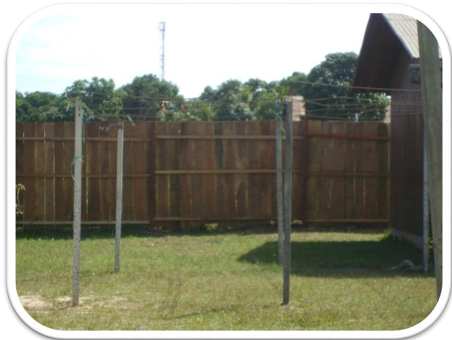
Vista del Cerco de Madera instalado por los padres de familia de manera provisional
