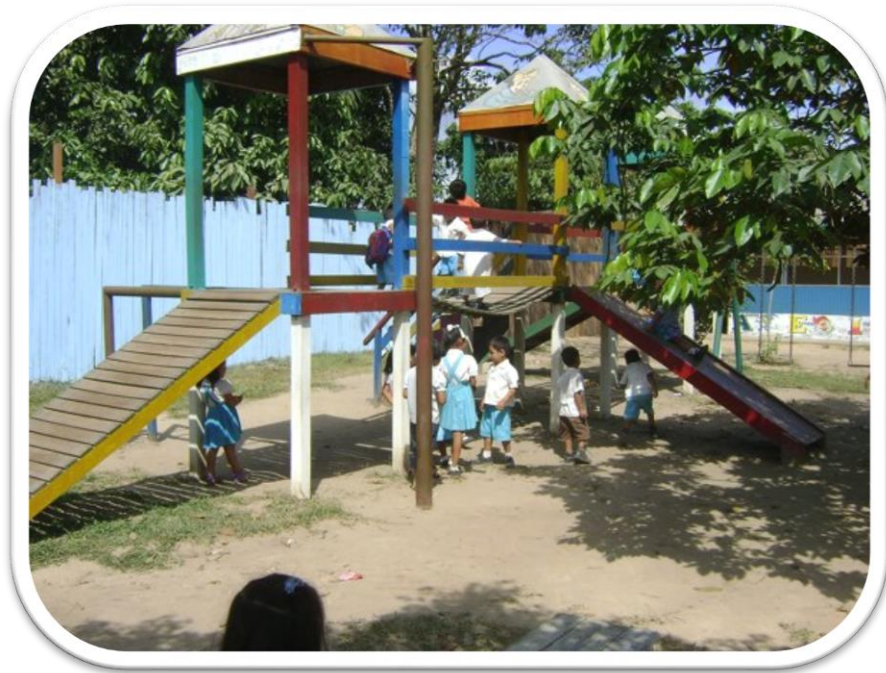
Vista de juego infantil de madera en deterioro, resulta un peligro
