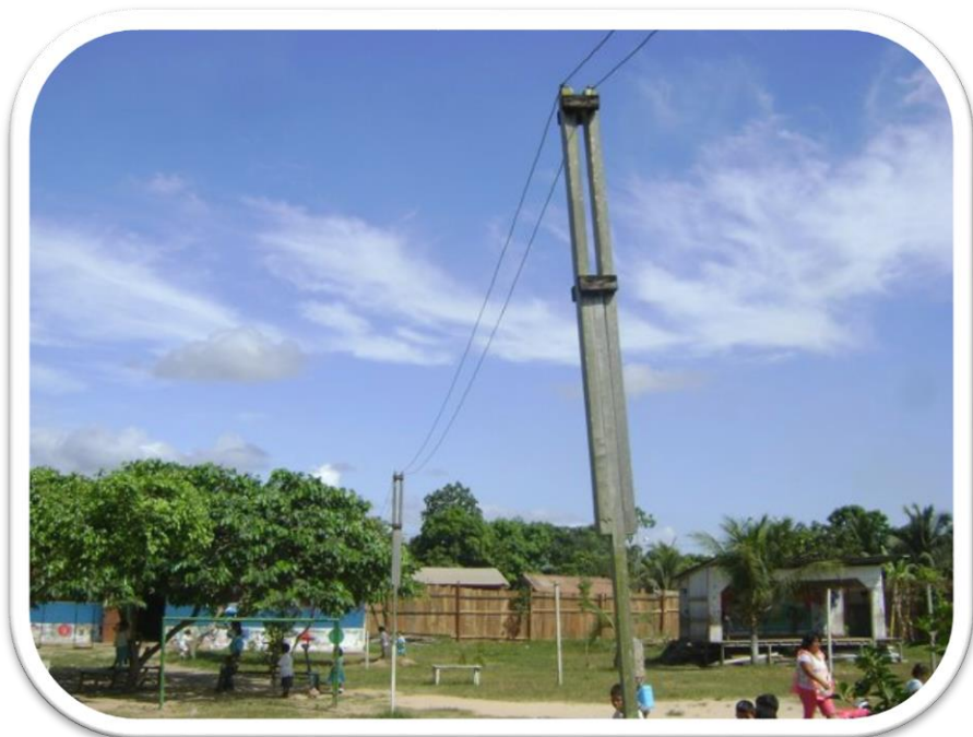
Se Observa los postes de madera inadecuados que cruzan la I.E.I.
