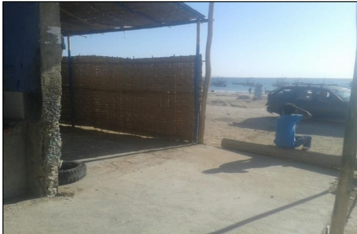
Imagen N° 10: Columna en mal estado a causa de los sulfatos, quedando el acero expuesto al ambiente marino.
