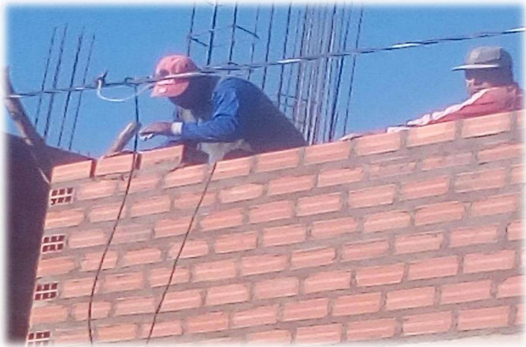
**IMAGEN N° 07:** En la imagen se puede observar el asentado de muro con ladrillo pandereta en aparejo de sogá de la primera jornada de trabajo.
