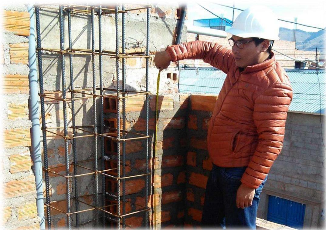
**IMAGEN N° 12:** En la imagen se puede observar el muro asentado con ladrillo pandereta en aparejo de sogá y realiza las mediciones correspondientes de la jornada de trabajo.
