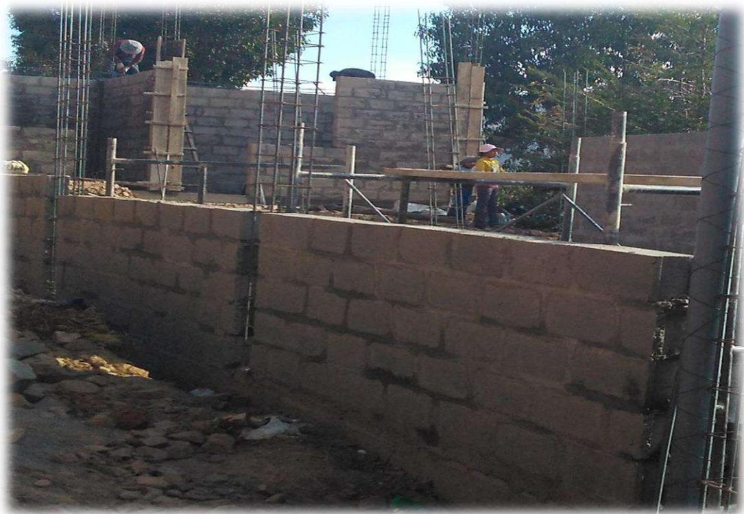
**IMAGEN N° 17:** En la imagen se puede observar el asentado de muro con bloques de concreto en aparejo de soga de la primera jornada de trabajo.
