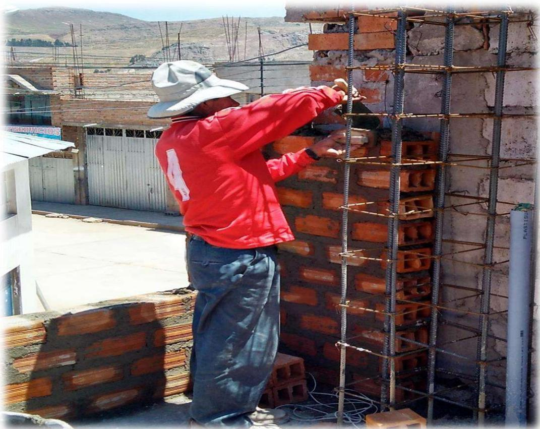
**IMAGEN N° 08:** En la imagen se puede observar el asentado de muro con ladrillo pandereta en aparejo de sogá de la primera jornada de trabajo.
