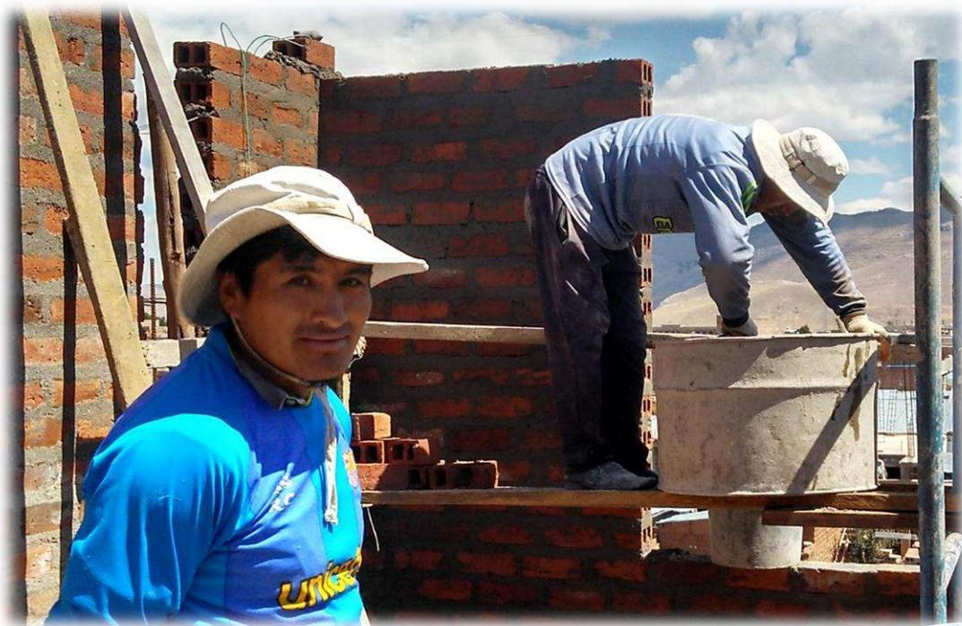
**IMAGEN N° 16:** En la imagen se puede observar el asentado de muro con ladrillo pandereta en aparejo de sogá de la segunda jornada de trabajo.
