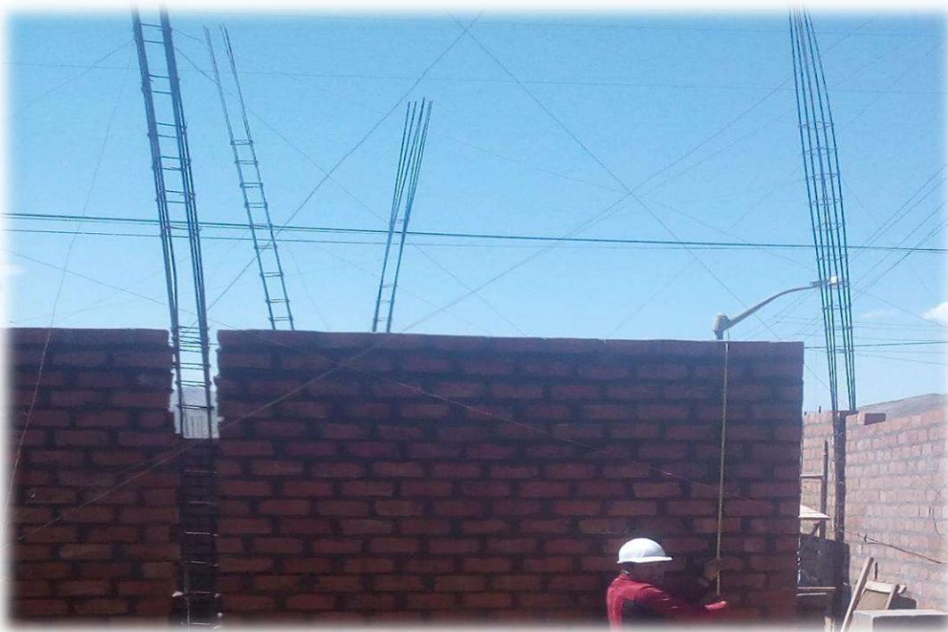
**IMAGEN N° 04:** En la imagen se puede observar el muro asentado con ladrillo King Kong de arcilla en aparejo de soga y realizando las mediciones correspondientes de la segunda jornada de trabajo.
