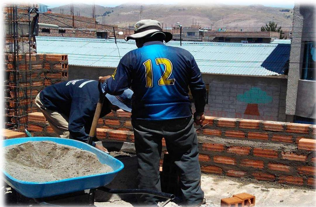
**IMAGEN N° 11:** En la imagen se puede observar el asentado de muro con ladrillo pandereta en aparejo de sogá, preparación de mezcla de la primera jornada de trabajo.
