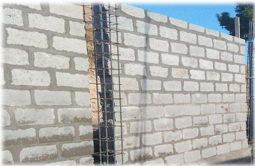
**IMAGEN N° 18:** En la imagen se puede observar el asentado de muro con bloques de concreto en aparejo de soga de la primera y segunda jornada de trabajo.
