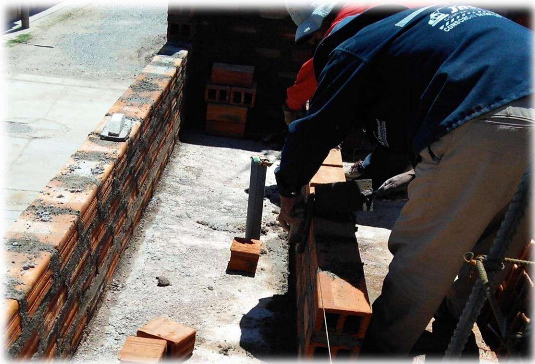
**IMAGEN N° 13:** En la imagen se puede observar el asentado de muro con ladrillo pandereta en aparejo de sogá de la primera jornada de trabajo.
