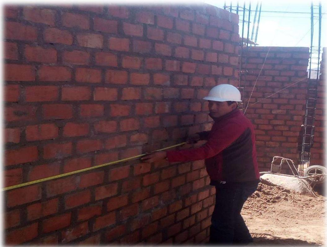
**IMAGEN N° 06:** En la imagen se puede observar el muro asentado con ladrillo King Kong de arcilla en aparejo de sogá y realiza las mediciones correspondientes de la jornada de trabajo.
