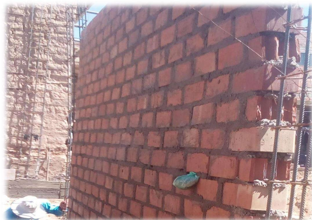
**IMAGEN N° 02:** En la imagen se puede observar el muro asentado con ladrillo King Kong de arcilla en aparejo de sogá de la segunda jornada de trabajo.
