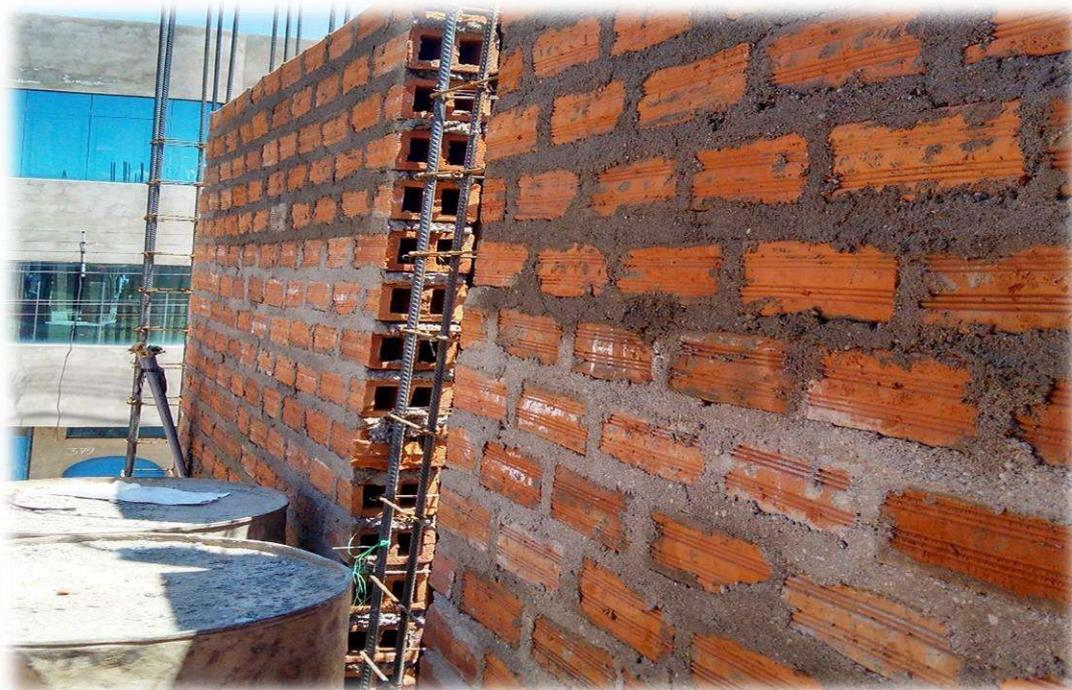
**IMAGEN N° 09:** En la imagen se puede observar el asentado de muro con ladrillo pandereta en aparejo de soga de la primera y segunda jornada de trabajo.
