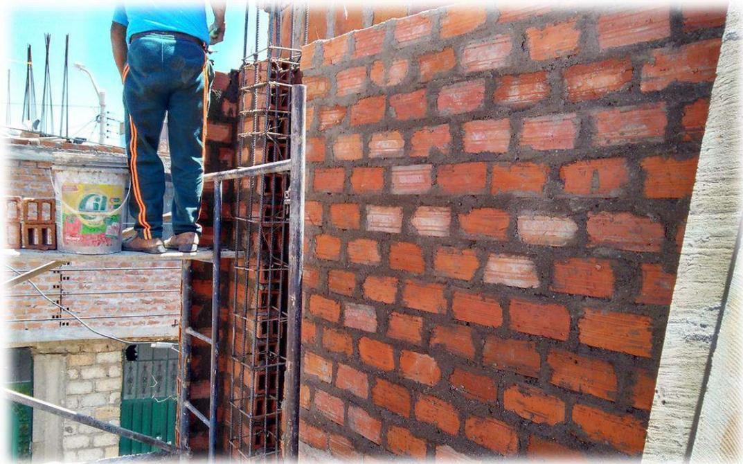
**IMAGEN N° 15:** En la imagen se puede observar el asentado de muro con ladrillo pandereta en aparejo de sogá de la segunda jornada de trabajo.
