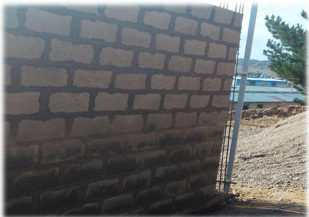
**IMAGEN N° 18:** En la imagen se puede observar el asentado de muro con bloques de concreto en aparejo de soga de la primera y segunda jornada de trabajo.
