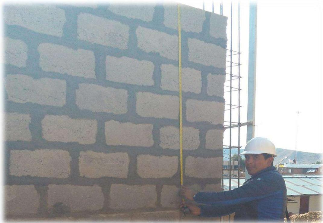
**IMAGEN N° 19:** En la imagen se puede observar el muro asentado con bloques de concreto en aparejo de soga y realiza las mediciones correspondientes de la jornada de trabajo.
