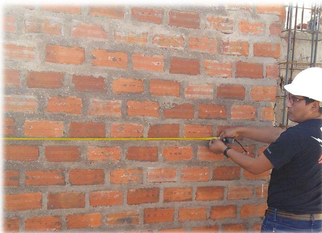
**IMAGEN N° 10:** En la imagen se puede observar el muro asentado con ladrillo pandereta en aparejo de soga y realiza las mediciones correspondientes de la jornada de trabajo.
