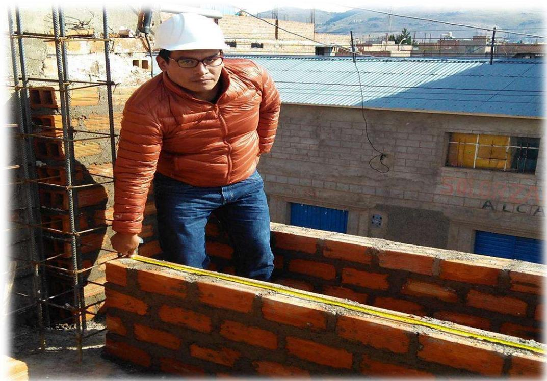
**IMAGEN N° 14:** En la imagen se puede observar el muro asentado con ladrillo pandereta en aparejo de sogá y realiza las mediciones correspondientes de la jornada de trabajo.
