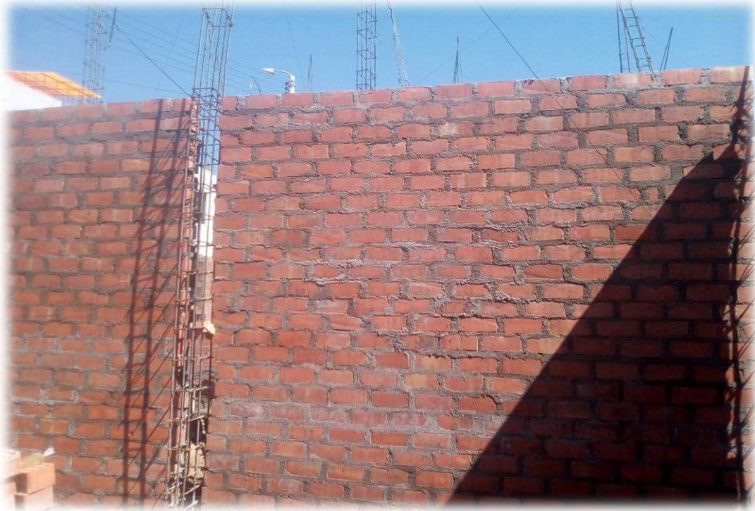
**IMAGEN N° 05:** En la imagen se puede observar el muro asentado con ladrillo King Kong de arcilla en aparejo de sogá de la primera y segunda jornada de trabajo.
