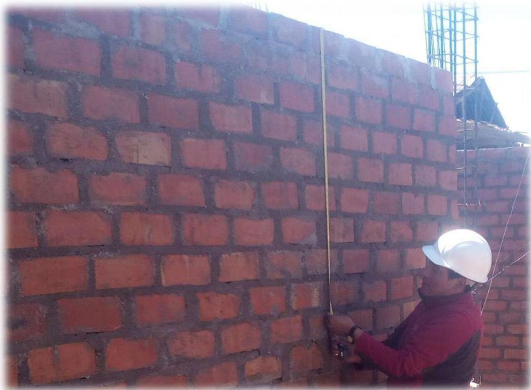
**IMAGEN N° 03:** En la imagen se puede observar el muro asentado con ladrillo King Kong de arcilla en aparejo de soga y realizando las mediciones correspondientes de la segunda jornada de trabajo.
