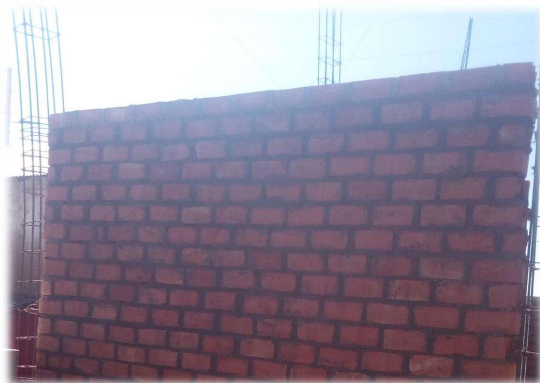
**IMAGEN N° 01:** En la imagen se puede observar el asentado de muro con ladrillo King Kong de arcilla en aparejo de sogá de la primera jornada de trabajo.
