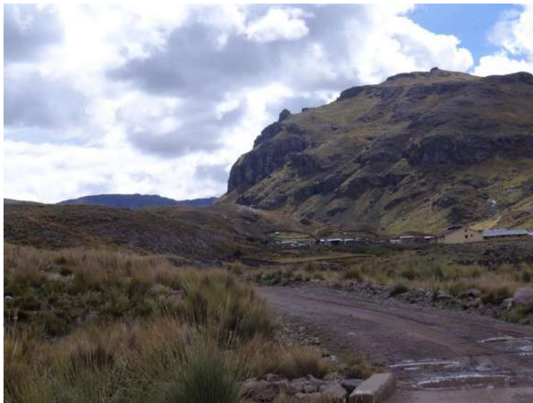
FOTO 10. Vista Panorámica de la Trocha Carrozable Progresiva 12+450
