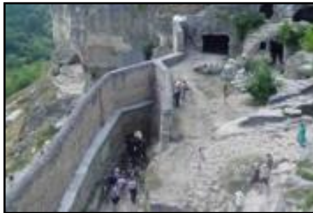
Figura 2 - 5: Construcción en Chokrak
