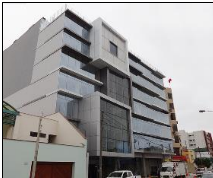
Figura 2 - 17: Nueva Sede de Graña y Montero
