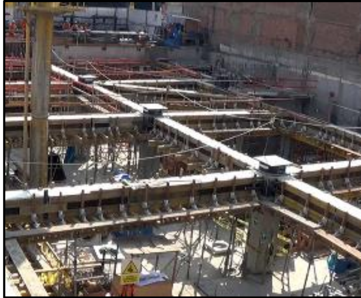
Figura 2 - 18: Colocación aisladores Sede Graña y Montero
