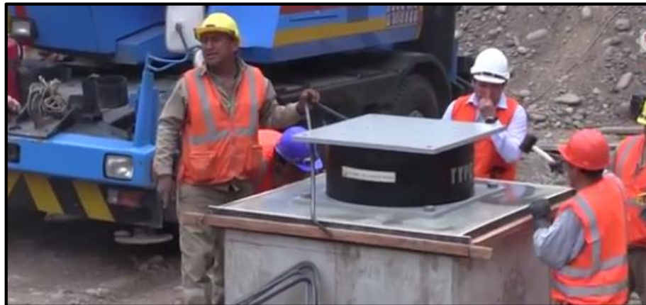
Figura 2 - 21: Colocación de aisladores FIC - UNI
