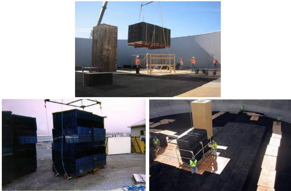
Figura N° 17: instalación de medias de filtros.
