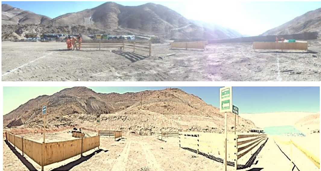
Imagen N° 08: Reutilización de madera proveniente de grating para sectorizar el centro de acopio.
