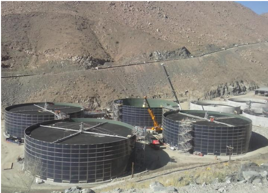
Imagen N°02: Tanques percoladores o Tricking Filter.
