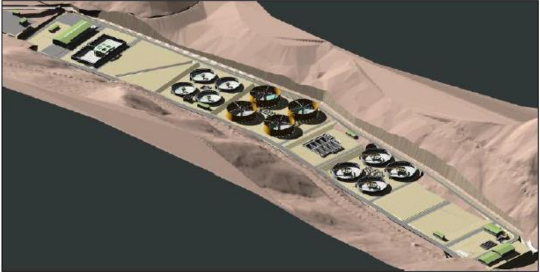
Imagen N°02: Tanques percoladores o Tricking Filter.
