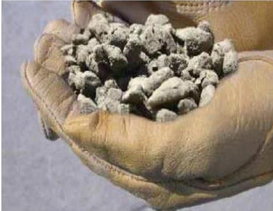
Figura 002: Concreto con muy poca agua.
