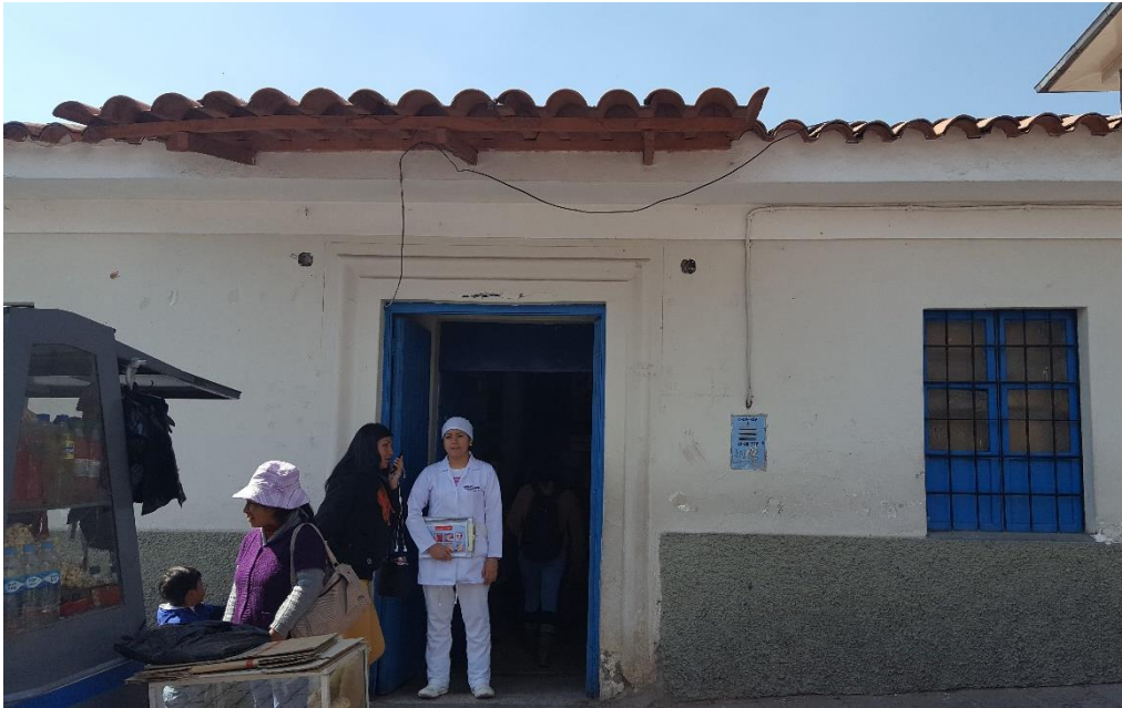
Fotografía N. °3: Fachada del Centro de Salud 7 Cuartones, de la ciudad del Cusco.
