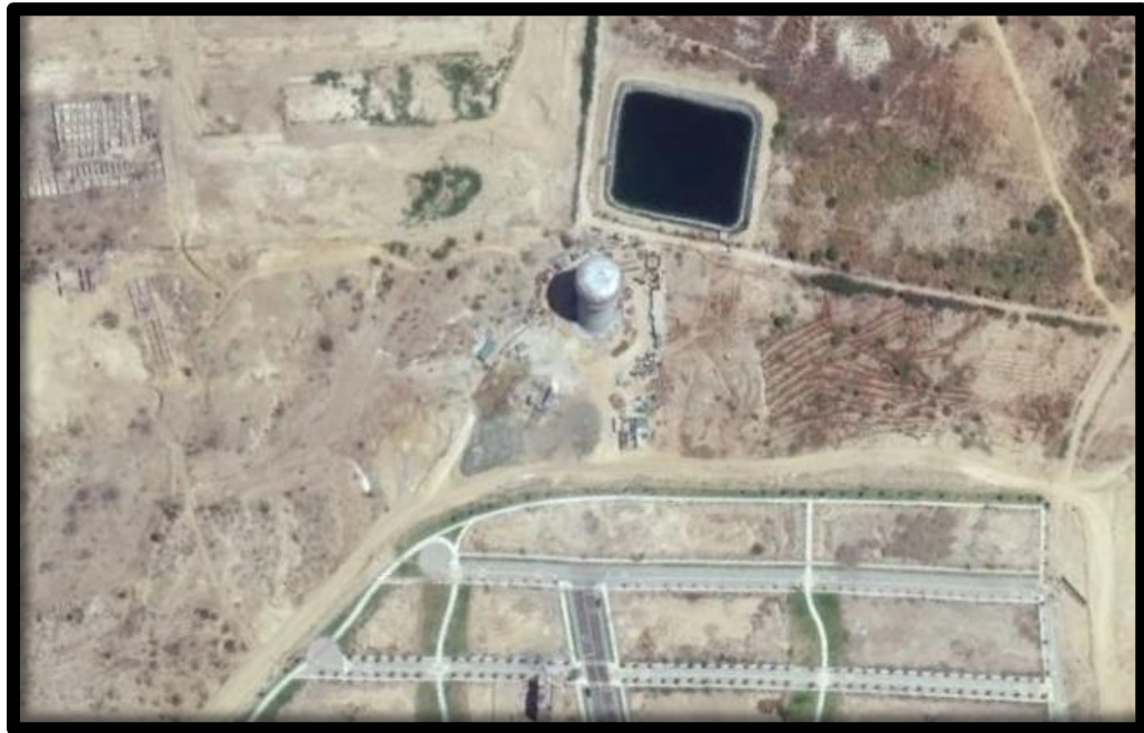
Figura 15. Ubicación de Reservorio Elevado
