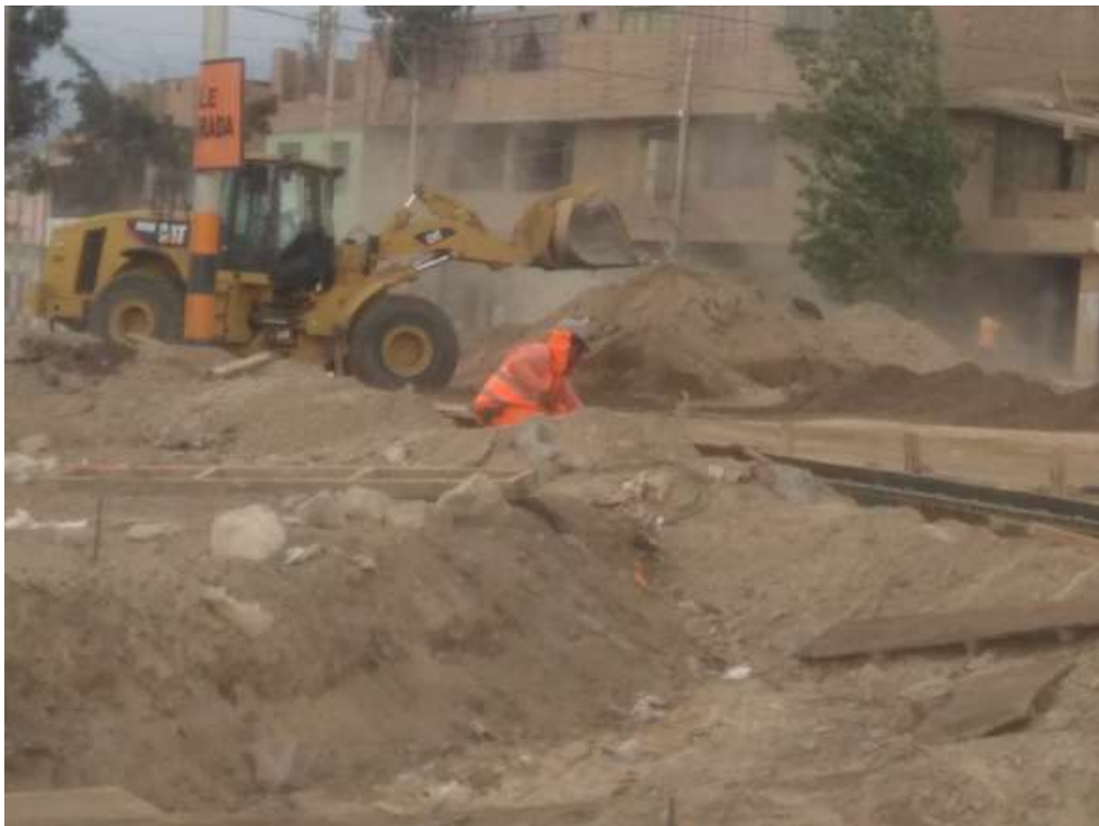
Fuente: foto del investigador en la Av. Arenales
